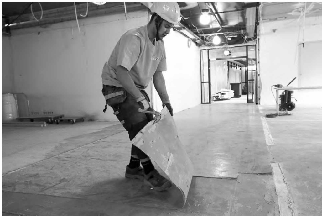
Kuva 3. Rakennusliikkeen työntekijä poistaa vanhaa muovimattoa. Kuvan henkilö ei ole kumpikaan hankkeen mittauspäivänä mattoja poistaneista rakennusmiehistä, mutta muuten työkohteeksi, työnkuva ja suojautuminen ovat vastaavat. Valokuva: Simo Porras, Työterveyslaitos, 2015.
