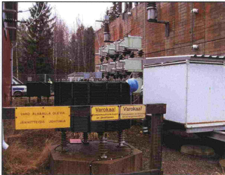
Kuva 6. Työskentelyä kuristimen ja vastuksen vieressä. Kuristimessa ei ole virtaa ja työntekijä on vastuksen takana.
