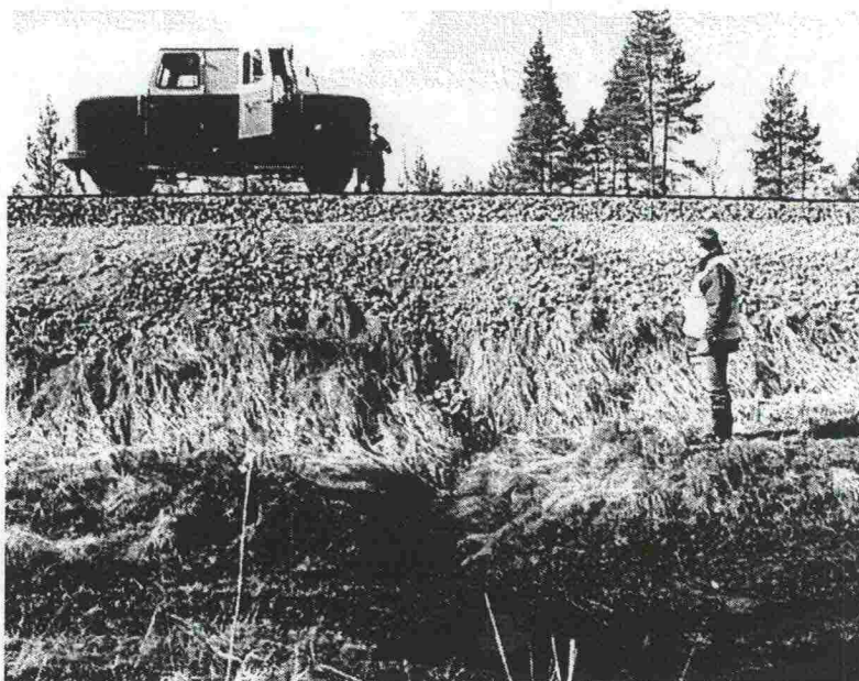
Kuva 5. 514, 714+875, Kivi/betoniputki, lyhyt molemmista päistä, jatkettava!
