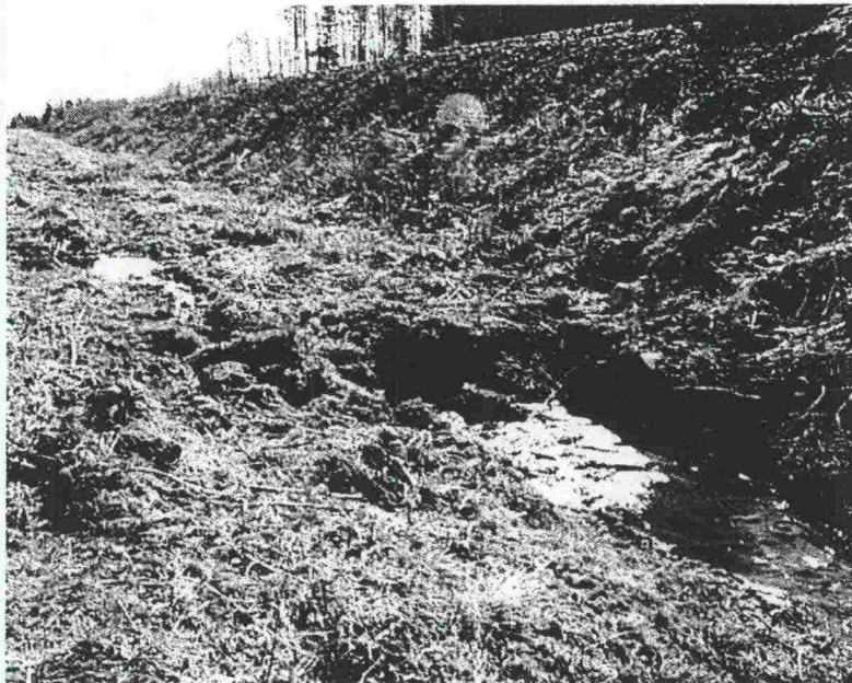
Kuva 11. 514, 722+937, Betoniputki, piti olla kivirumpu + betonikansi (ehkä vaihdettu tai jatkettu)
