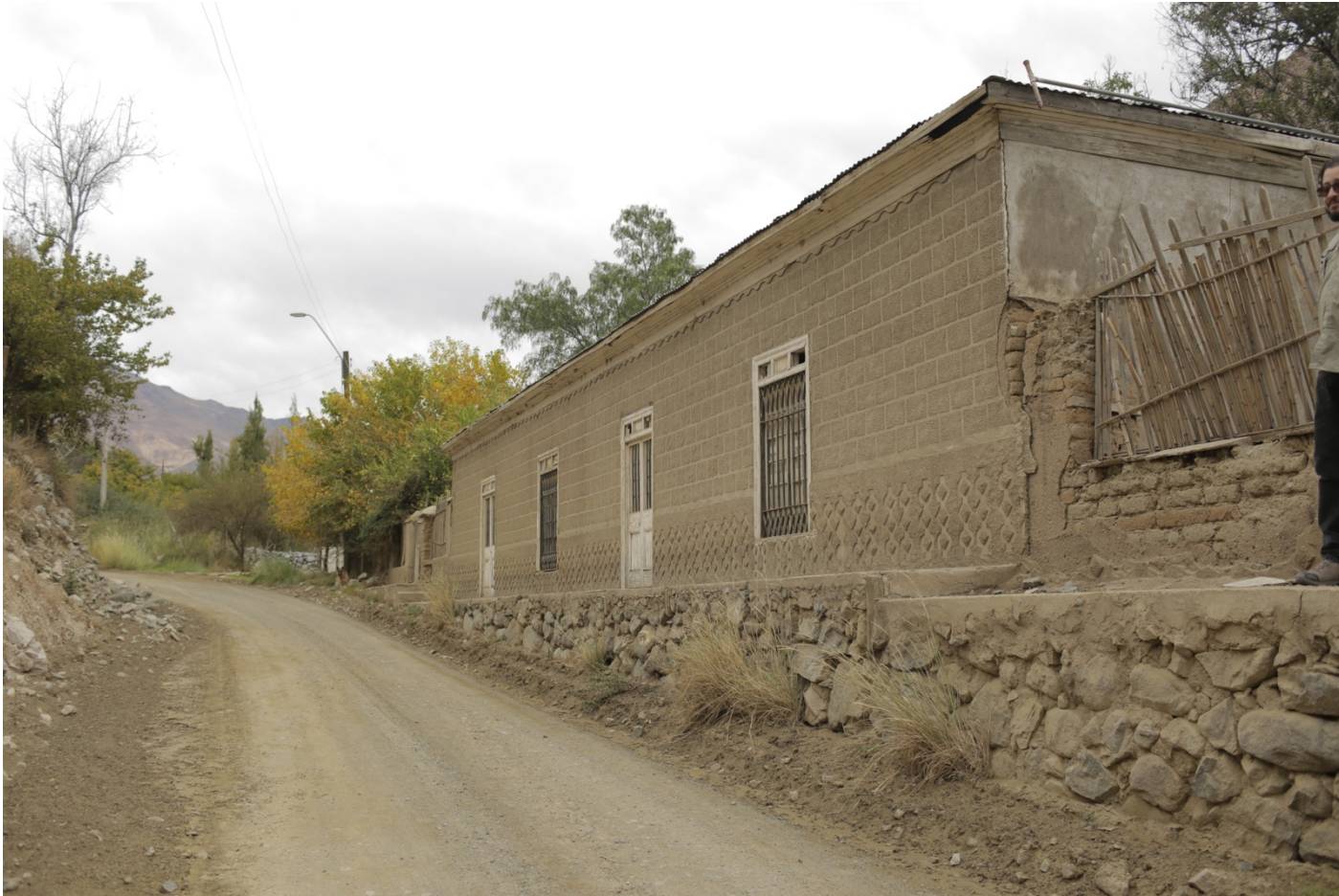
Figura 30. Perspectiva desde el poniente de la Casa Valenzuela inserta en el paisaje. Autor: Guillermo Ribbeck.
