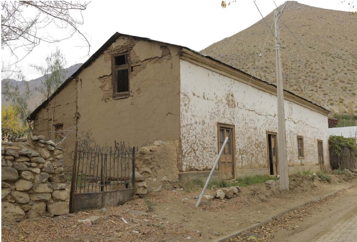
Figura 36: Fotografía fachada casa Callejas 2; Autor: Guillermo Ribbeck.
