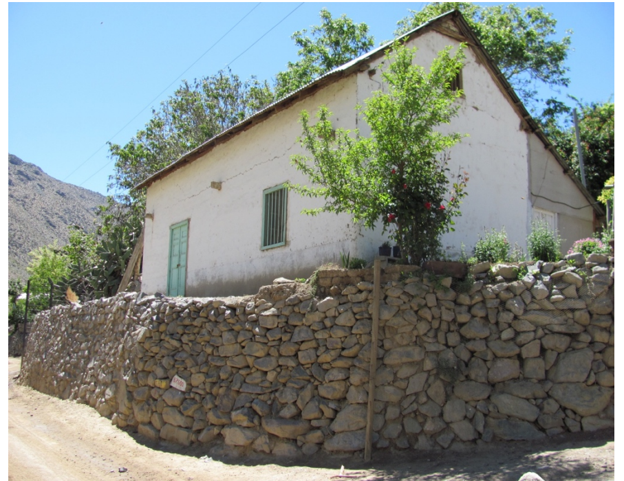
Figura 61: Pirca como plataformas de construcción. Autor: Iván Maureira.
