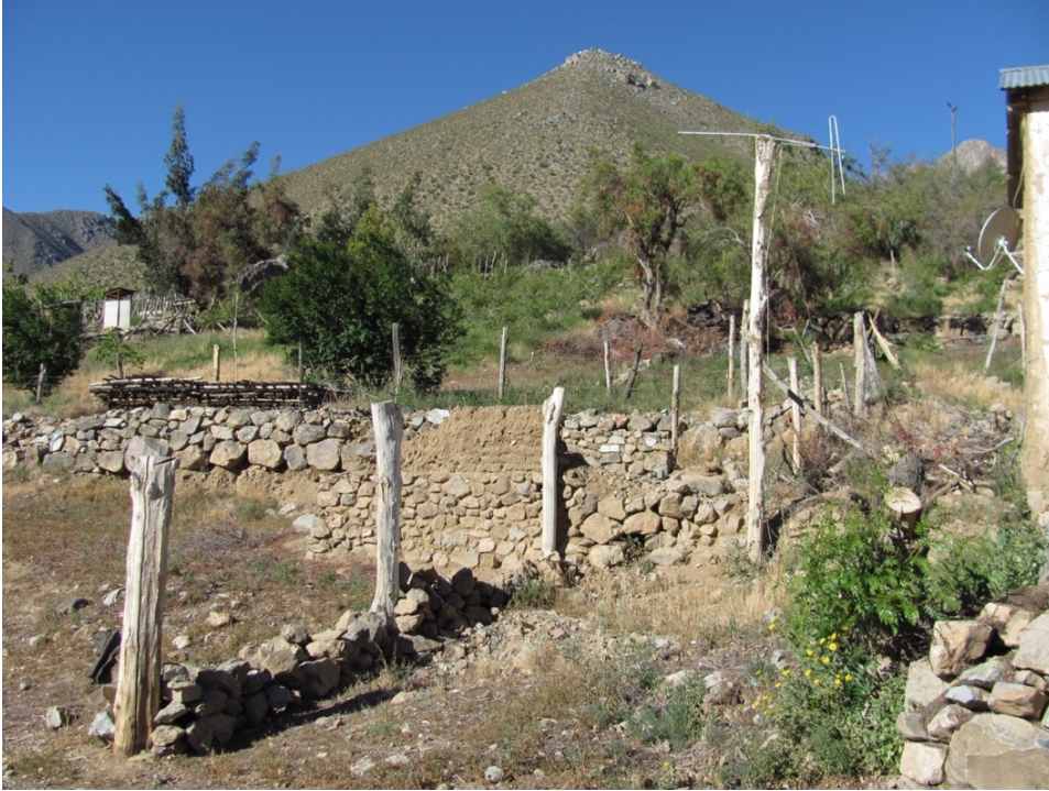
Figura 12: vista cerro El Arenoso. Autor: Iván Maureira.
