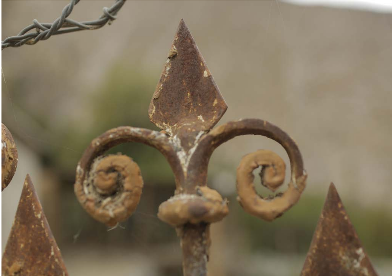
Figuras 31. Detalle de reja forjada de casa. Autor: Guillermo Ribbeck.
