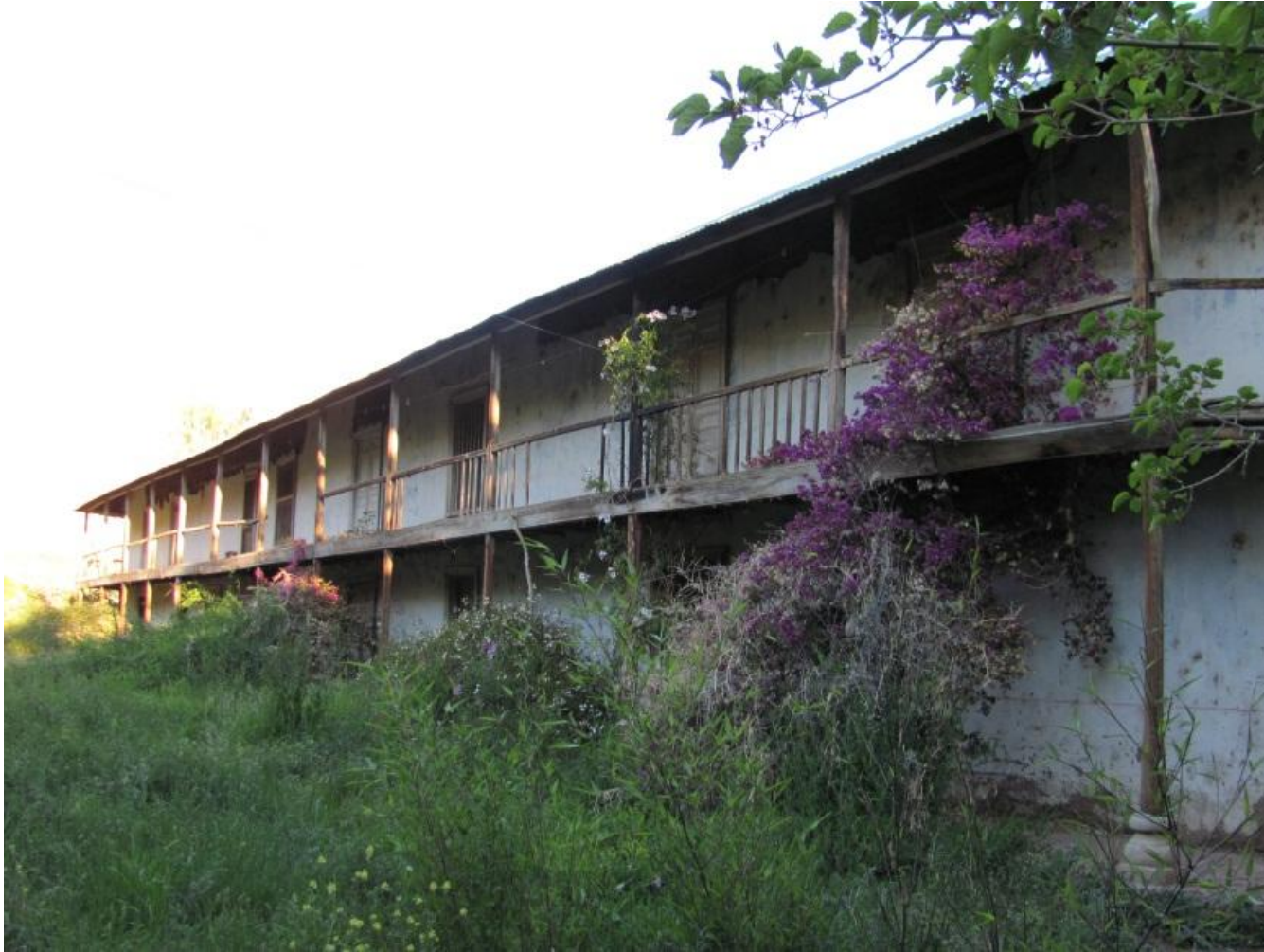
Figura 23. Fachada con balcón corrido. Autor: Iván Maureira.
