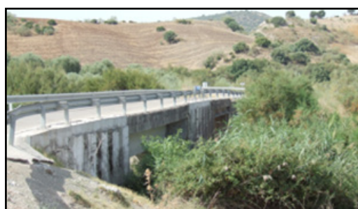
Foto 24. ID_tramo 6. Viaducto. X: 296420,31 Y: 4115570,21. Autora: Joya, 2013.
