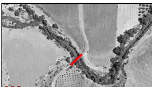
Foto 23. Foto aérea ID_tramo 6. Viaducto. X: 296420,31 Y: 4115570,21. Fuente: COPT, 2013.
