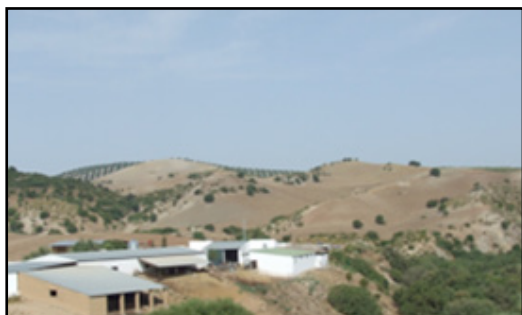
Foto 50. ID_punto 3. Edificación aislada agrícola. X: 296013,37 Y: 4114671,52. Autora: Joya, 2013.
