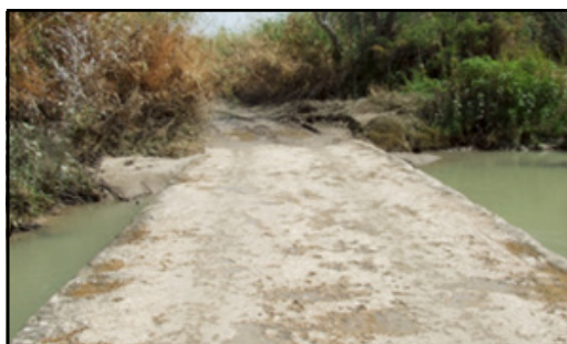
Foto 30. ID_tramo 14. Viaducto rancho metro. X: 292100,88 Y: 4127309,83. Autora: Joya, 2013.
