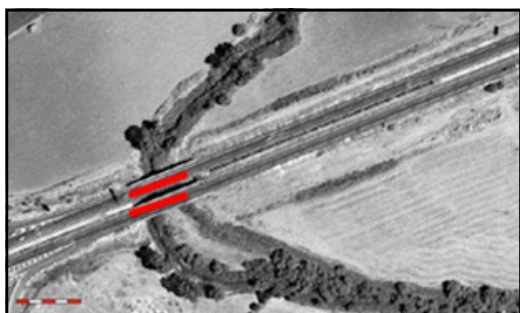
Foto 27. Foto aérea ID_tramo 13. Viaducto A-92. X: 294370,56 Y: 4123349,84. Fuente: COPT, 2013.
