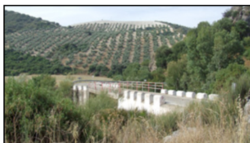
Foto 22. ID_tramo 2. Viaducto Junta de los ríos. X: 296613,04 Y: 4113089,51. Autora: Joya, 2013.
