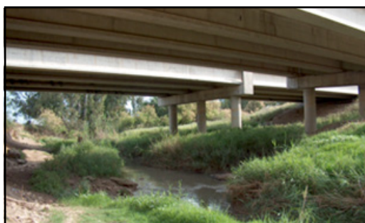
Foto 28. ID_tramo 13. Viaducto A-92. X: 294370,56 Y: 4123349,84. Autora: Joya, 2013.
