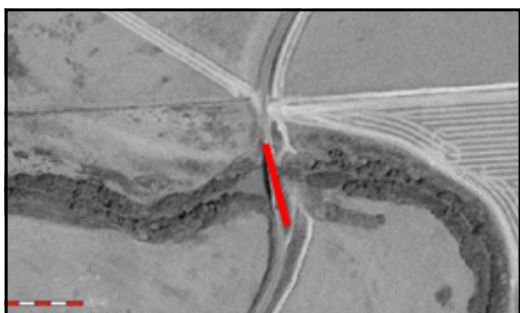
Foto 37. Foto aérea ID tramo 29. Viaducto el grullo. X: 284126,44 Y: 4141851,61. Fuente: COPT, 2013.
