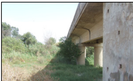
Foto 32. ID_tramo 20. Viaducto ctra Marchena-Lantejuela. X: 291815,97 Y: 4133466,58. Autora: Joya, 2013.
