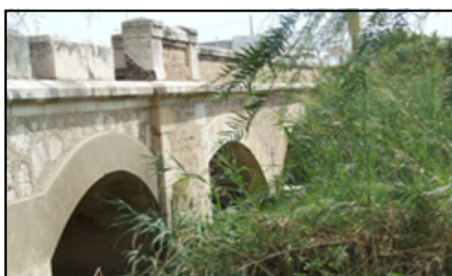
Foto 18. ID_tramo 12. Puente de La Puebla de Cazalla. X: 295868,23 Y: 4122765,53. Autora: Joya, 2013.
