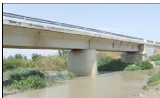
Foto 38. ID tramo 29. Viaducto el grullo. X: 284126,44 Y: 4141851,61. Autora: Joya, 2013.
