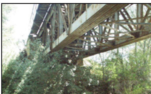
Foto 34. ID_tramo 21. Viaducto ferrocarril. X: 291728,36 Y: 4133600,9. Autora: Joya, 2013.
