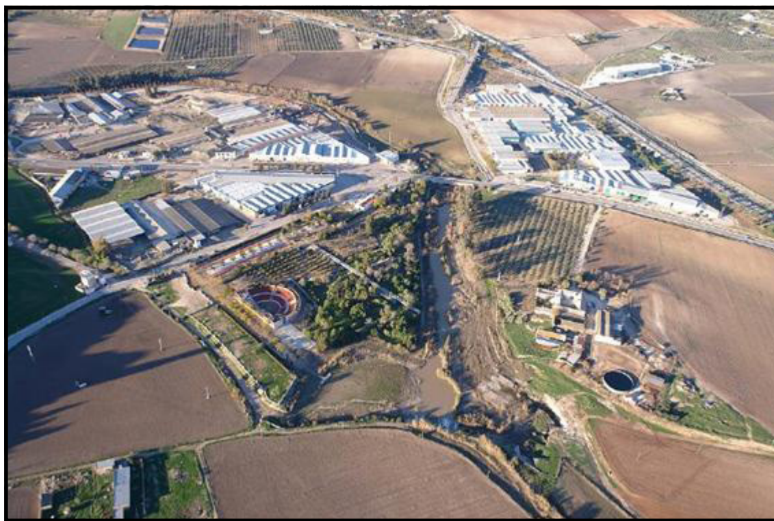
Foto 16. Paso del río Corbones por el polígono industrial de La Puebla de Cazalla. Autor: Andrade, sin fecha.
