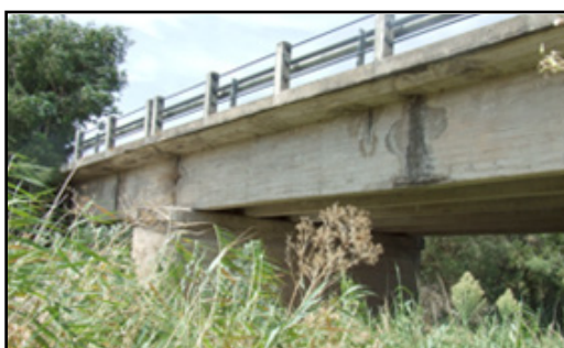
Foto 36. ID_tramo 25. Viaducto ctra Marchena-Écija. X: 290579,31 Y: 4137635,05. Autora: Joya, 2013.
