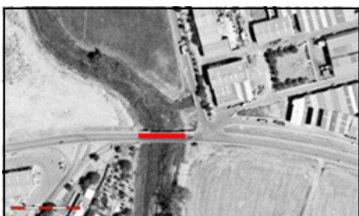
Foto 17. Foto aérea ID_tramo 12. Puente de La Puebla de Cazalla. X: 295868,23 Y: 4122765,53. Fuente: COPT, 2013.
