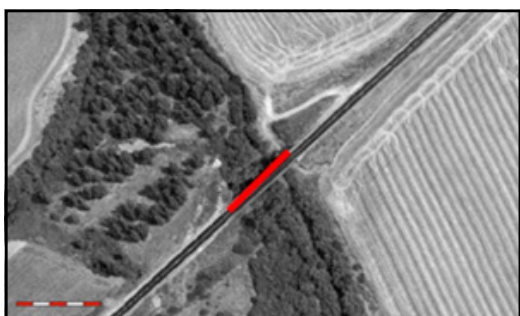
Foto 35. Foto aérea ID_tramo 25. Viaducto ctra Marchena-Écija. X: 290579,31 Y: 4137635,05. Fuente: COPT, 2013.
