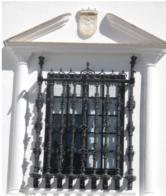
Fig. 23.- Reja sevillana en la fachada del palacio. Fotografía: M a Paz Pérez.
