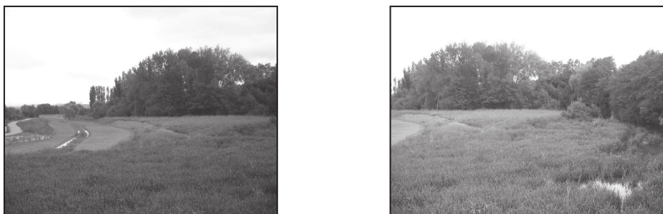
Fig. 7. Vista de la confluencia del cauce artificial con el cauce natural
