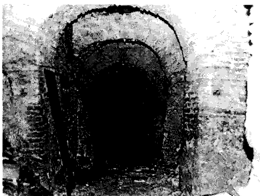
Figura. 8 C/ Cristo de Rivas nº 2. Arquerías de ladrillo de la bodega.
