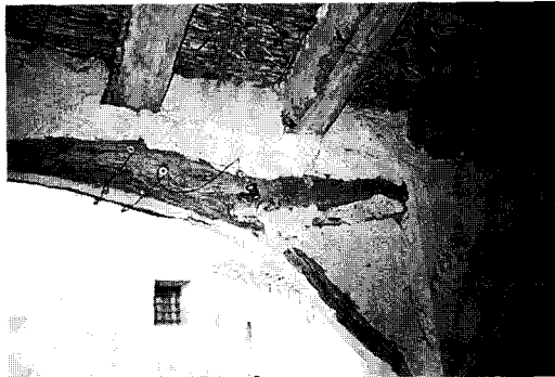
Figura 12 Vigas de tronco de palmera y olivo
