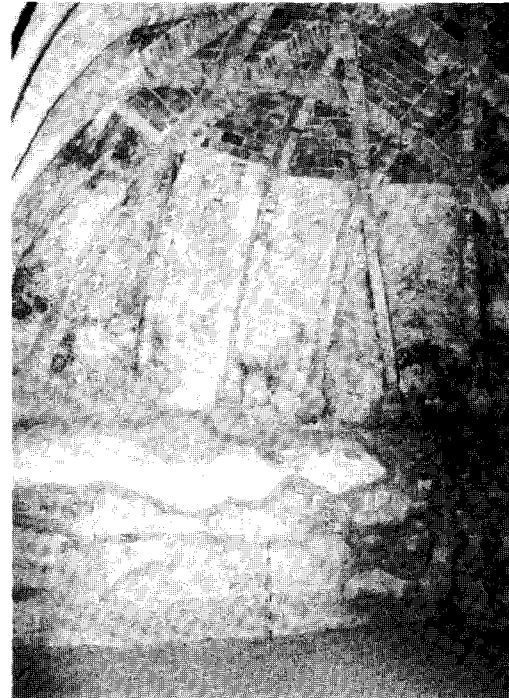
Figura 5 Vista bóveda piso 2º
