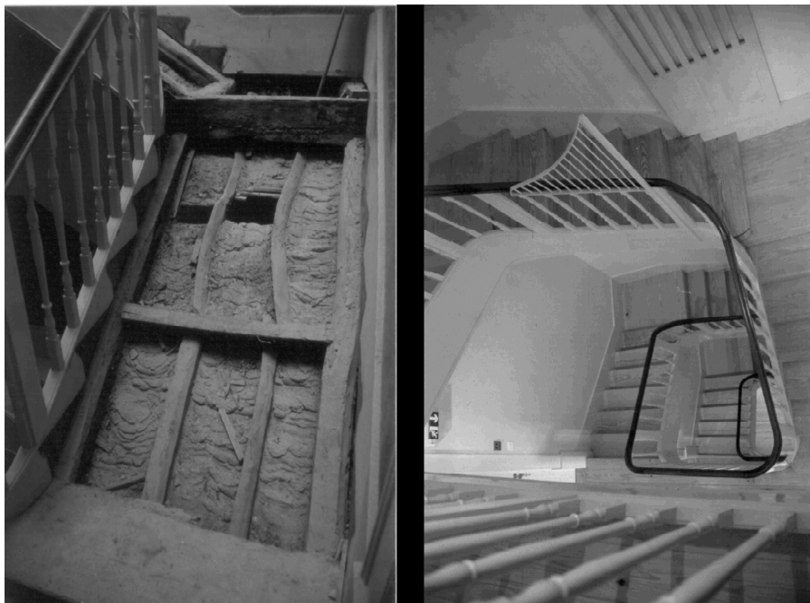
Fig. 7 “Escalera: (a) durante el proceso de deconstrucción y (b) después de la renovación”.
