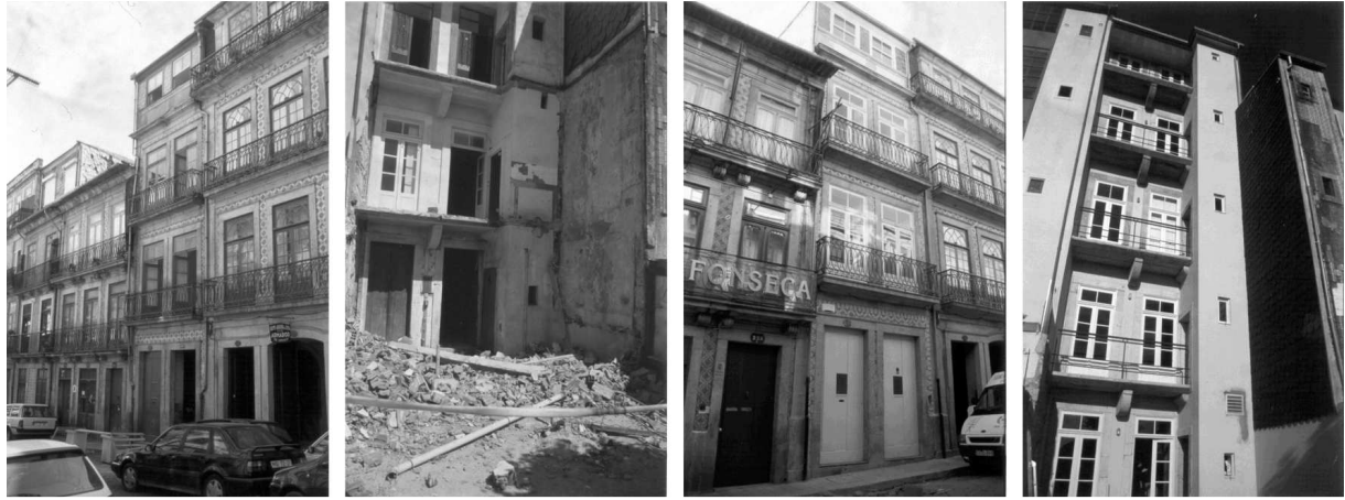
Fig. 6 Fachadas Norte y Sur: (a) antes y (b) después de la renovación.
