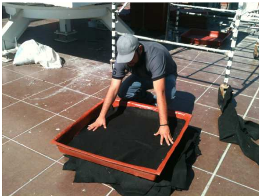
Fig. 9 “Colocación de geotextil”
