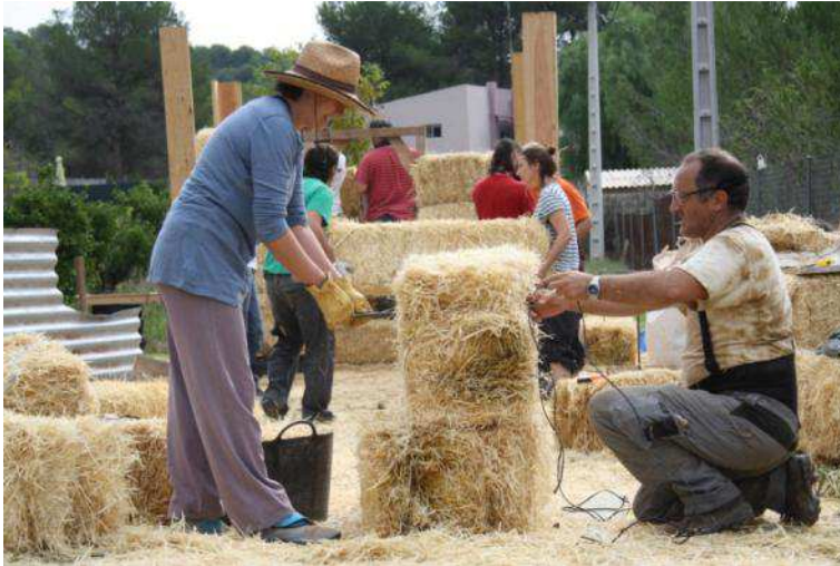
Fig.7 “Manipulación de la Bala de Paja en obra de muros autoportantes” Fuente: okambuva.coop
