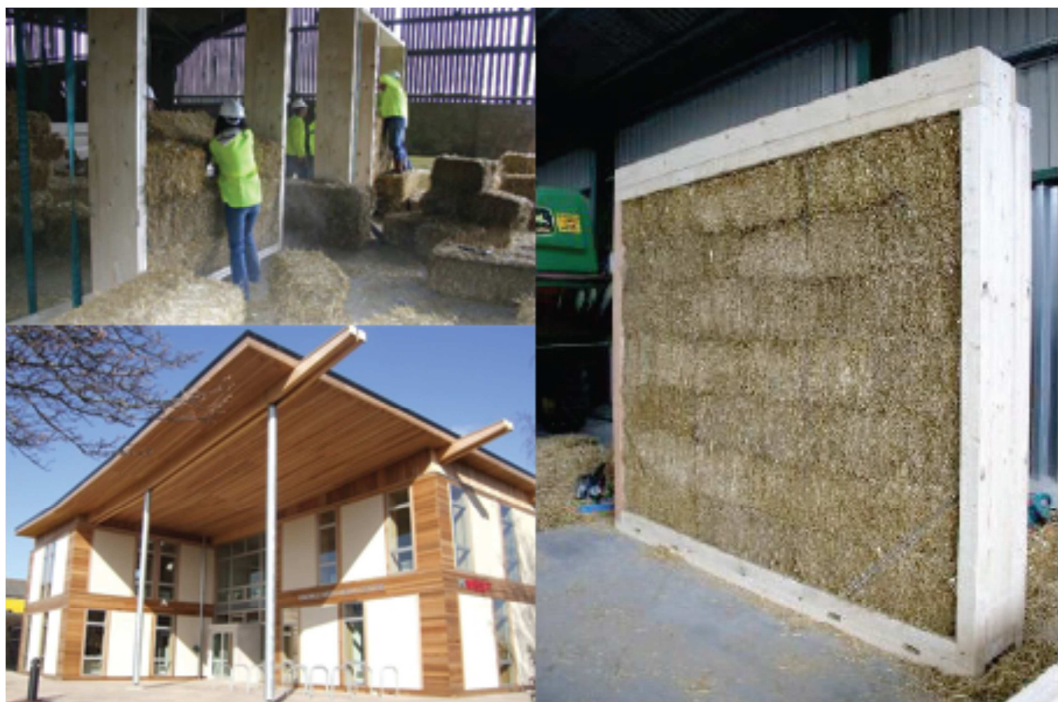
Fig.8 “Modcell, Reino Unido, módulos prefabricados de hasta 3x3m”.
