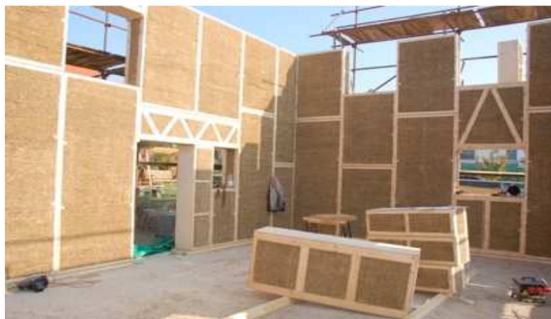
Fig.12 “Montaje de cerramientos en casa unifamiliar” Fuente: ecocon.it
