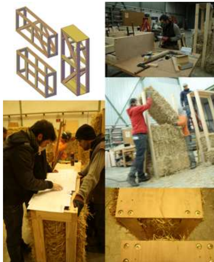
Fig.10 “Montaje de los módulos alfaWALL” Fuente: okambuva.coop
