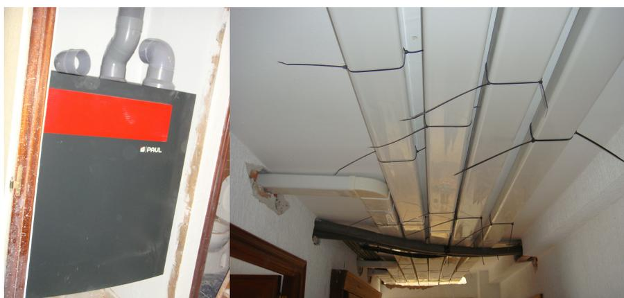
**Fig. 3** Recuperador de calor y sistema de conductos de renovación de aire
