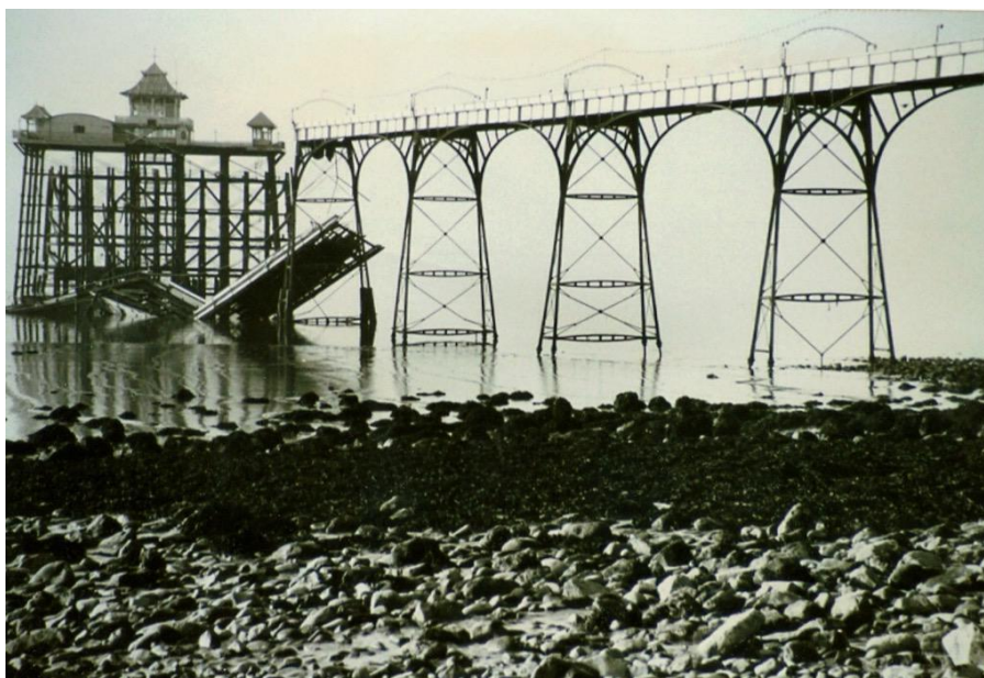
Fig. 7 Hundimiento en el extremo del muelle. ( http://clevedonpier.co.uk .2016)
