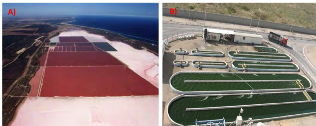
Figura 10. A) Estanque natural para la producción de Dunaliella (Cognis, West Australia) B) Reactores tipo raceway con diferentes volúmenes en Israel (Seambiotic Ltd.)
