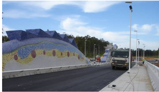
Fig.8. Medida de las vibraciones inducidas por el tráfico rodado en un puente.
