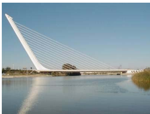
Fig. 1. El Puente del Alamillo.
