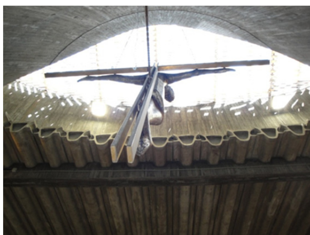
Figura 6.1.6. Lucernario, crucifijo y vigas hueso.
