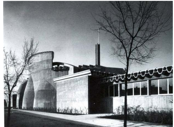
Figura 2.84. Exterior del complejo parroquial de Santa Ana de Moratalaz. Madrid, 1965.
