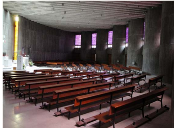
Figura 2.90. Huecos para iluminación en paramentos verticales. Iglesia del colegio de la Asunción Cuestablanca. Madrid, 1965.
