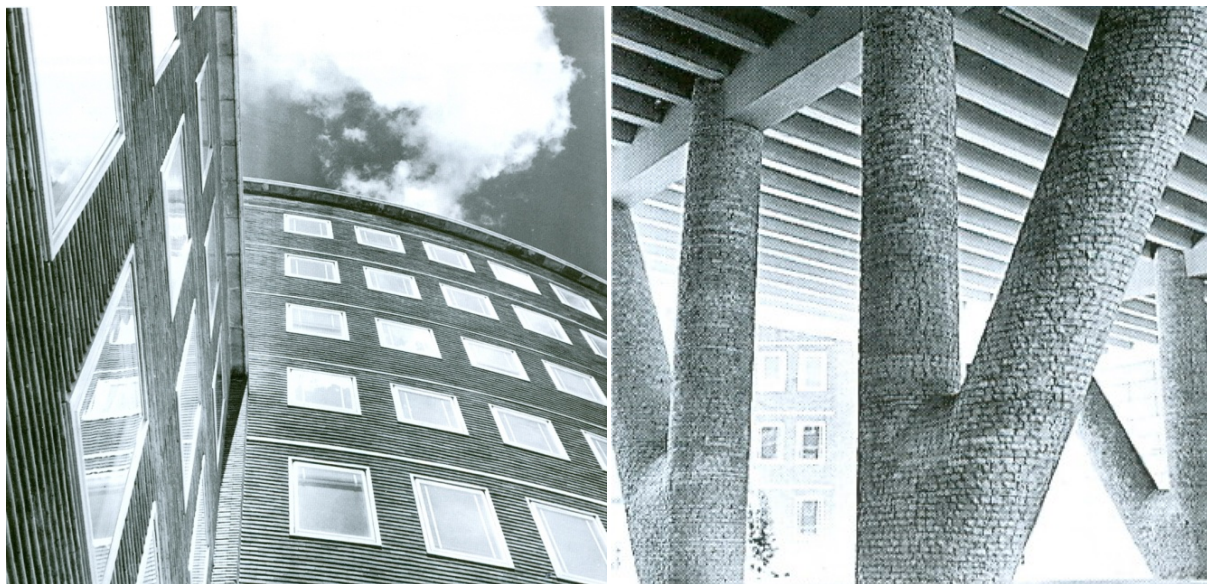
Figura 2.13. Exterior y pilares inclinados del Instituto Ramón y Cajal de Microbiología. Madrid, 1949.
