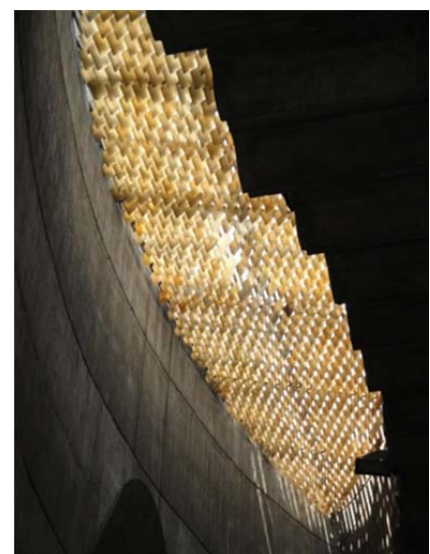
Figura 2.85. Lucernario sobre el presbiterio. Iglesia de Santa Ana de Moratalaz. Madrid, 1965.
