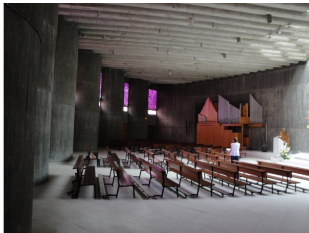
Figura 6.2.2. Vista interior lateral y muros dispersivos.
