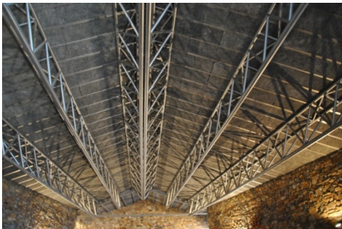
Figura 6.6.3. Detalle de estructura de cubierta.
