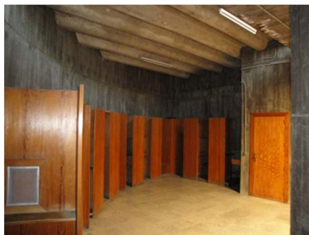
Figura 1.82. Confesionarios. Iglesia parroquial de Santa Ana. Madrid, 1965-1971. Arquitecto: Miguel Fisac.
