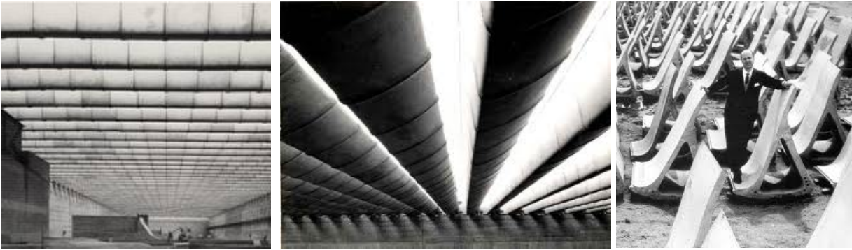
Figura 2.20. Interiores y vigas hueso del Laboratorio de Hidráulica. Madrid, 1961.
