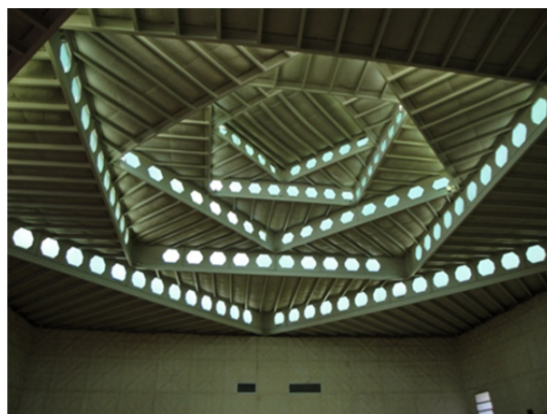
Figuras 6.5.3 y 6.5.4. Cubierta de la iglesia. Vigas Boyd, viguetas metálicas y entrevigado de hormigón.
