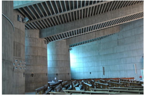
Figura 6.4.6. Muros dispersivos y estructura de cubierta.
