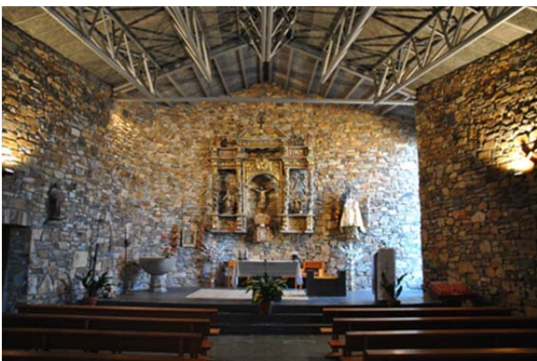
Figura 2.111. Vista interior hacia el presbiterio. Iglesia de Santiago, Pumarejo de Tera (Zamora), 1984.
