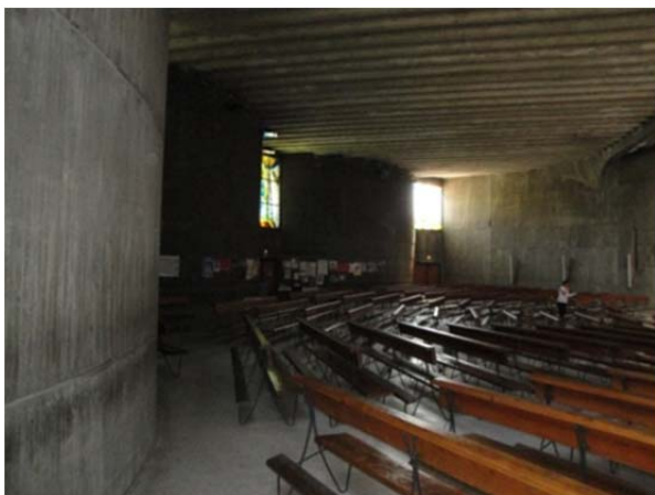
Figura 2.80. Muros dispersivos . Iglesia de Santa Ana de Moratalaz. Madrid, 1965.
