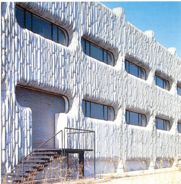
Figura 2.35 Edificio para talleres y oficinas de la Editorial Dólar S.A. Madrid. 1974.
