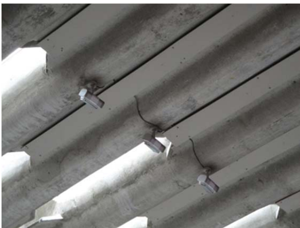
Figura 2.88. Vigas hueso con paneles de catón yeso en uniones. Iglesia del colegio de la Asunción Cuestablanca. Madrid. 1965.
