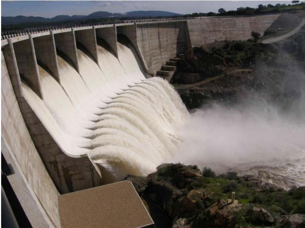
Figura 3-4. Presa vertedero con lanzamiento. (Presa de Melonares, provincia de Sevilla).
