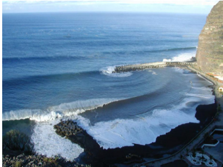
Figura 7-28. Difracción provocada por un dique (Por cortesía de Vicente Negro).
