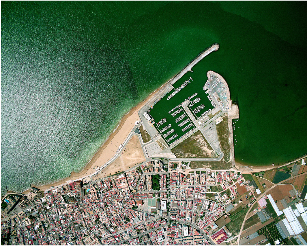
Figura 2-25. Vista aérea del Puerto de Chipiona (Cádiz).
