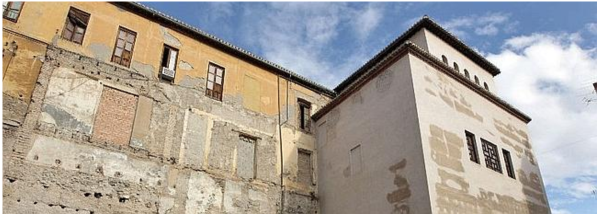
Cuarto Real de Santo Domingo. Edificio del siglo XIX y torre árabe del siglo XIII
