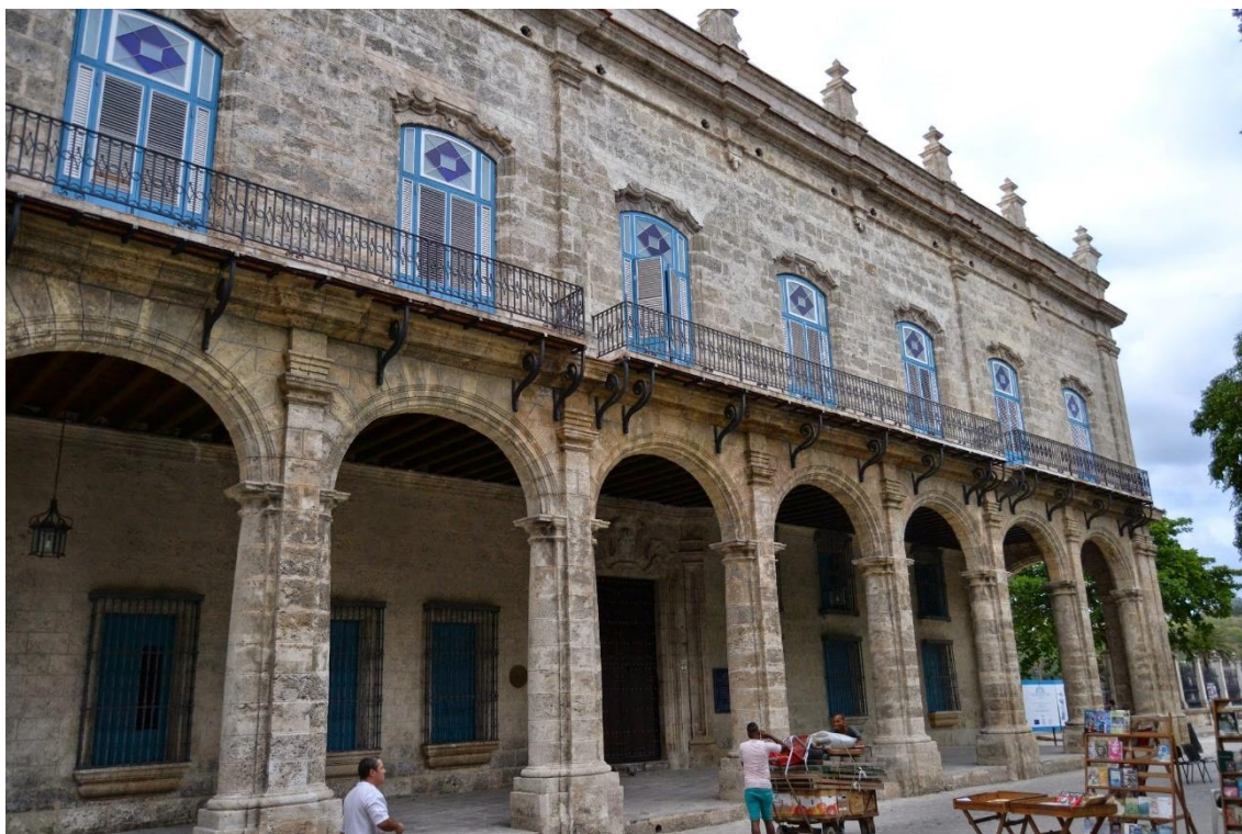
Ilustración 51. Edificio de la Renta de Correos marítima o Palacio del Segundo Cabo. Gentileza de Ignacio López Hernández.
