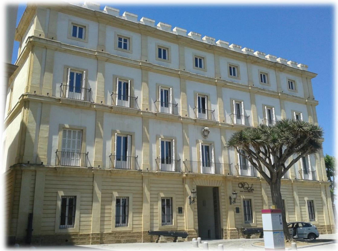
Ilustración 15. Silvestre Abarca, Pabellón de Ingenieros. En la actualidad, el edificio acoge el Centro Cultural Reina Sofía. Autor, Pedro Cruz.
