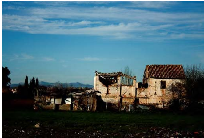
Fig. 17. Cortijo de las Ánimas, lugar de misterios, juego y diversión de varias generaciones de granadinos, hoy en ruinas (foto autor, 2010)
