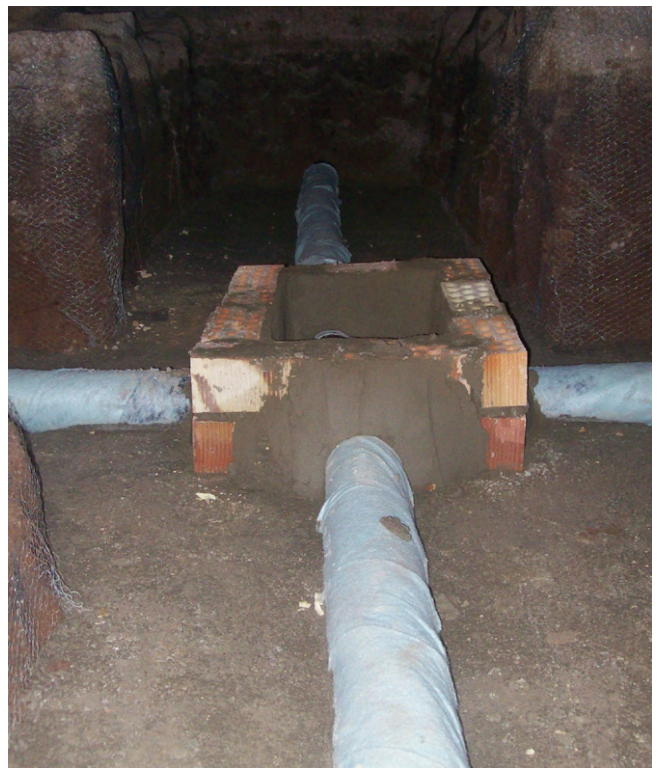
Figura 15. Disposición de red drenante
