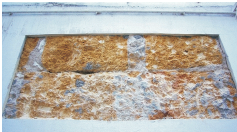
4. Cimiento en zanja corrida, bajo muro de fachada, ejecutado en fábrica de sillares de arenisca.
