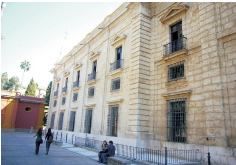
3. Escalera exterior de acceso a sótano de la Fábrica de Tabacos.
