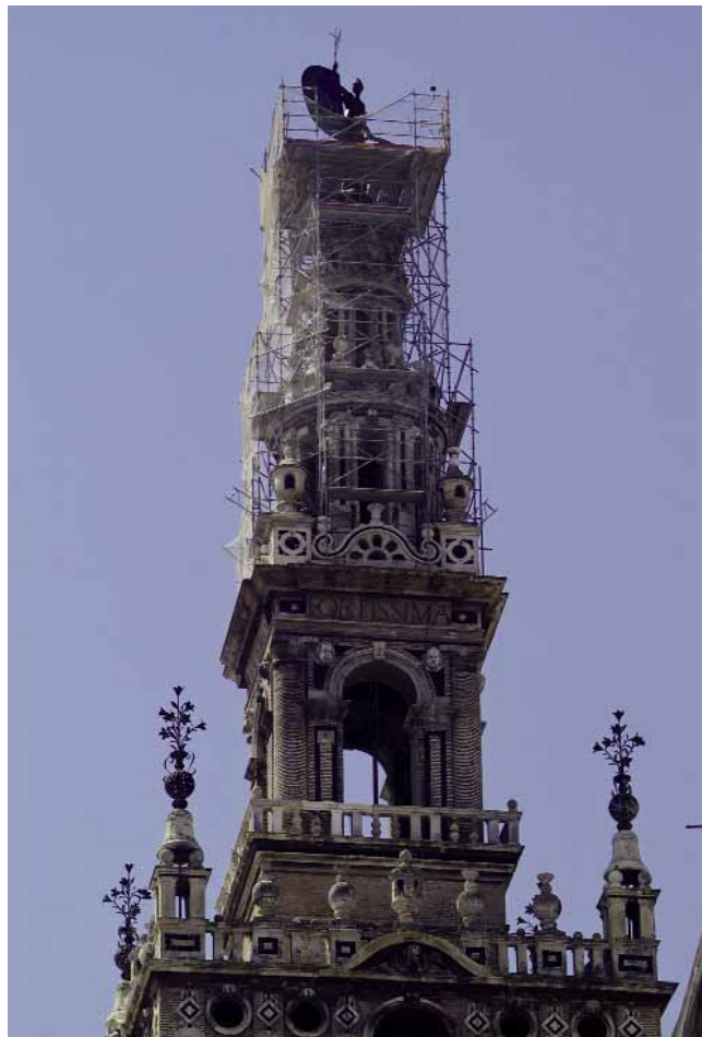
El Giralillo durante su reposición sobre la Giralda / FOTO: JOSÉ MANUEL SANTOS MADRID, IAPH
