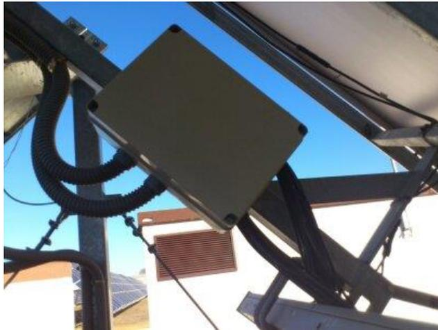
**Gráfico 18** String box anclada en la estructura de un seguidor
