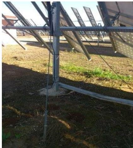
**Gráfico 13** Parte de la estructura de un sistema de seguidor a dos ejes
