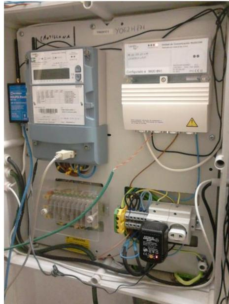
**Gráfico 19** Contador telemático con equipos de red para transmisión de datos
