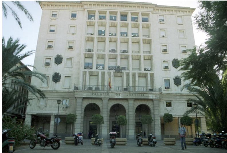
Figura 3-4. Fachada edificio Audiencia Provincial
