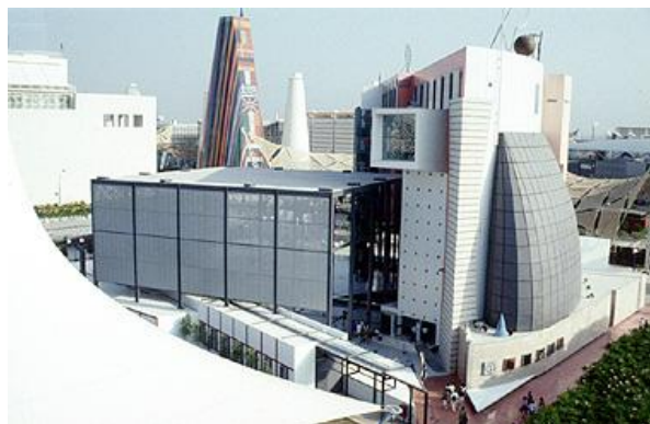
Figura 3-1. Edificio de la Agencia Andaluza de la Energía
