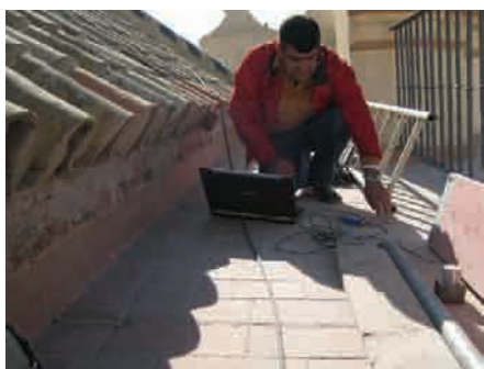
Figura 1: Medidas dinámicas en la cubierta de la Iglesia del Salvador.
