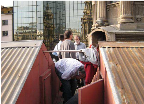
Colocación de acelerómetros en la cubierta de la Catedral de Santiago, acompañados del Ingeniero Acuña
