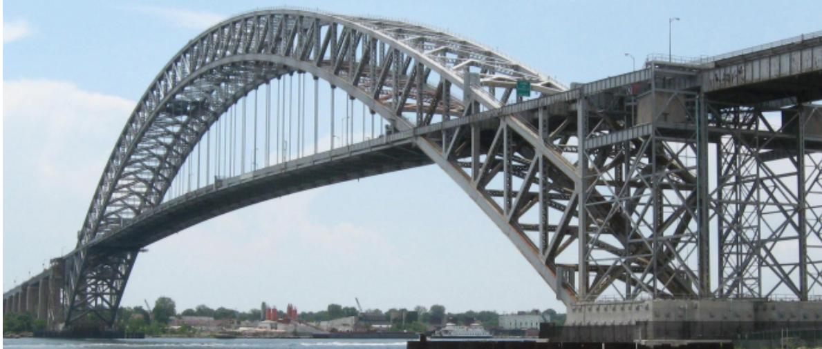
Figura 1.3 Puente Bayonne. Construido con acero (el más largo del mundo en el momento de su construcción 1931)
