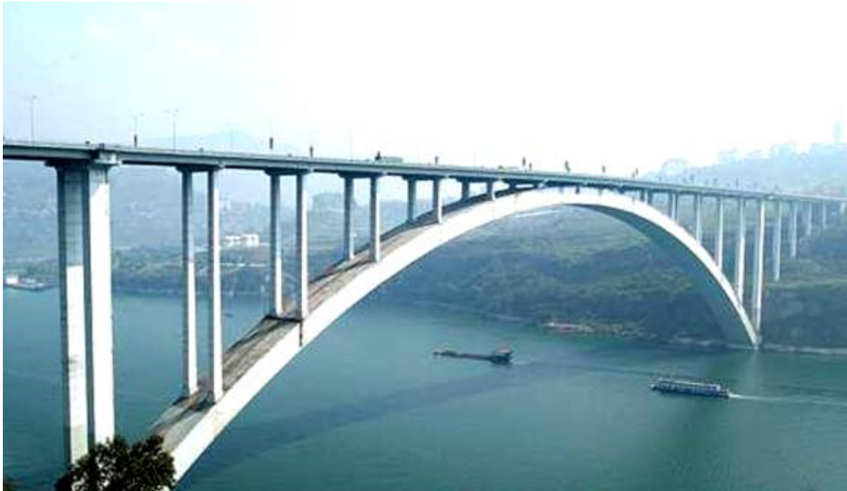
Figura 1.4 Puente Wanxian (China) Uno de los puentes arco de hormigón más grandes del mundo.
