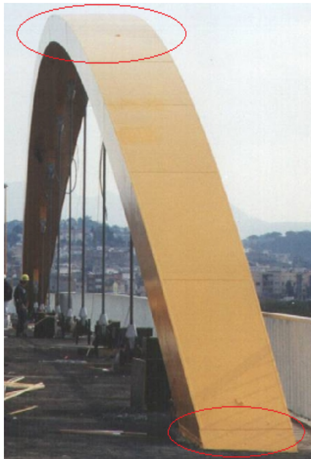
Figura 5.4 Puente arco con aumento de sección sobre el río Júcar
