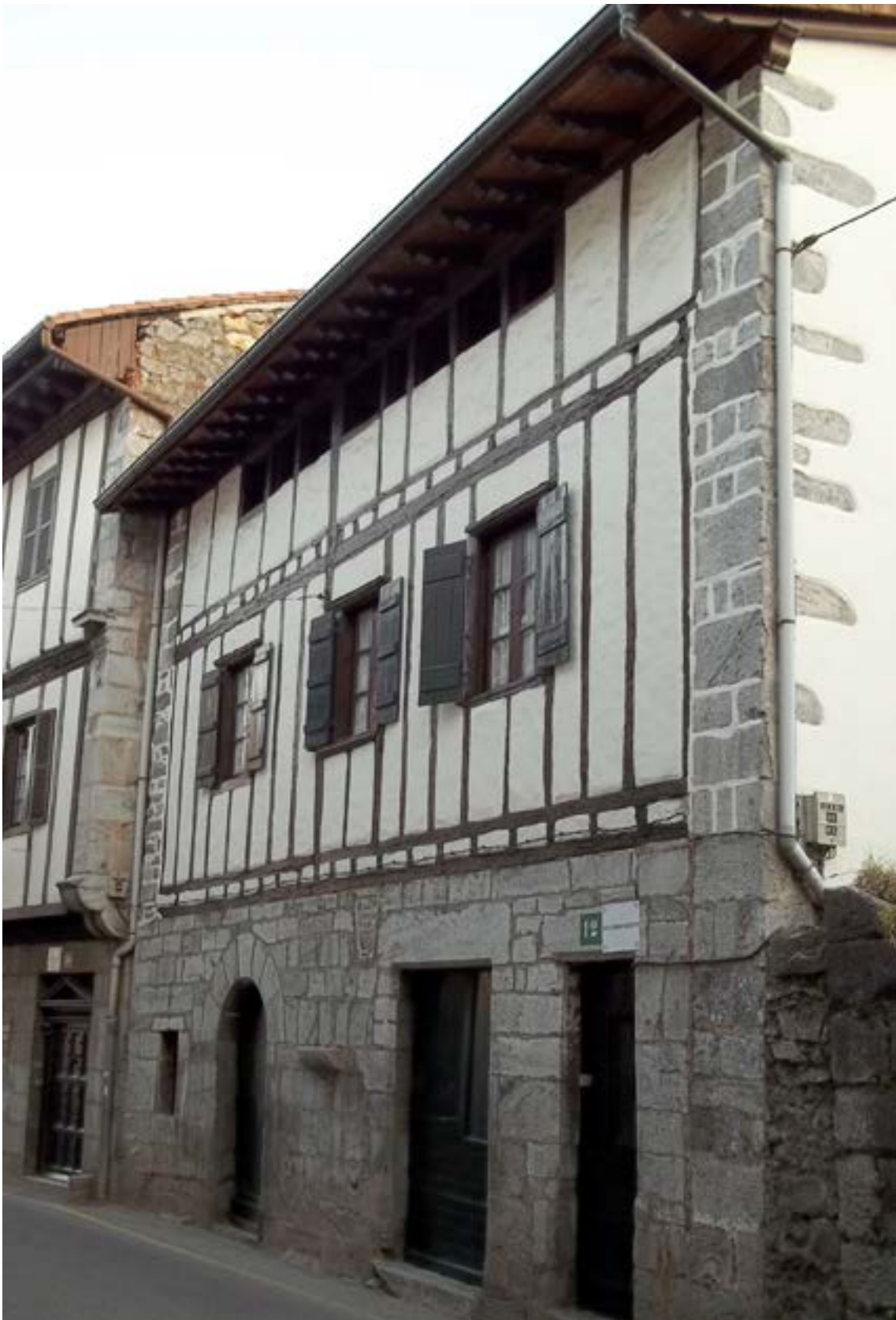
Figura 21. Casa Gillemontobaita, otro ejemplo de construcción del siglo XVI
