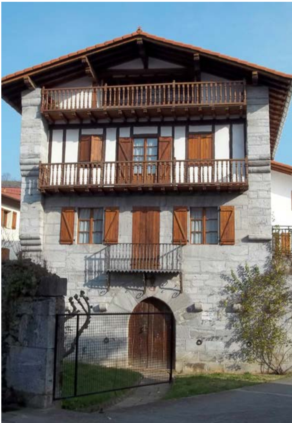
Figura 24. La casa Bikuinenea, en la plaza Berria, se levantó hacia finales del siglo XVI o comienzos del XVII
