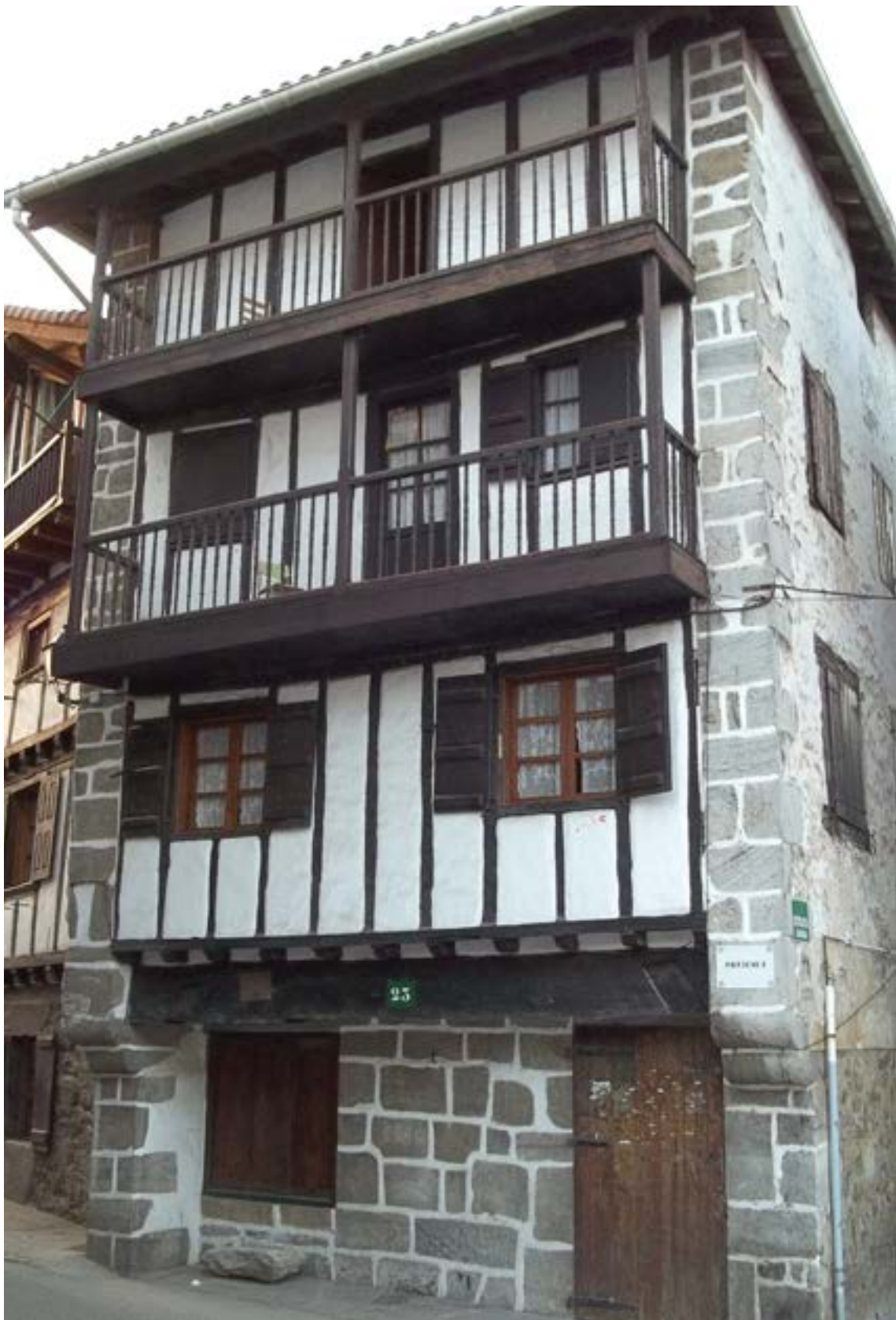
Figura 28. Casa Abasenea, otro edificio característico de Lesaka
