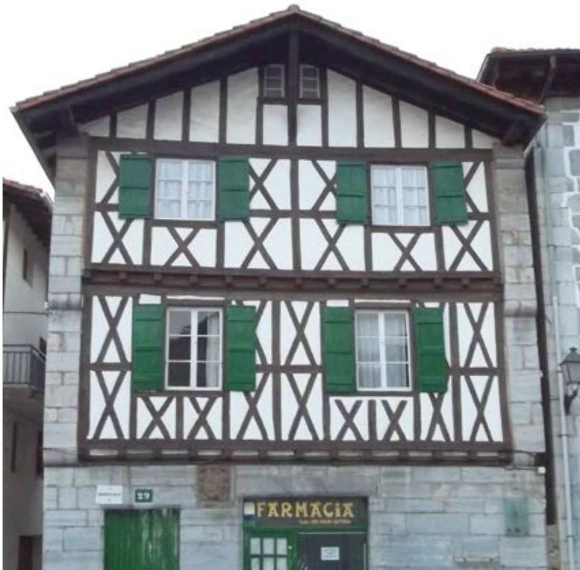
Figura 30. Entramado de madera en la fachada principal de Munuzenea
