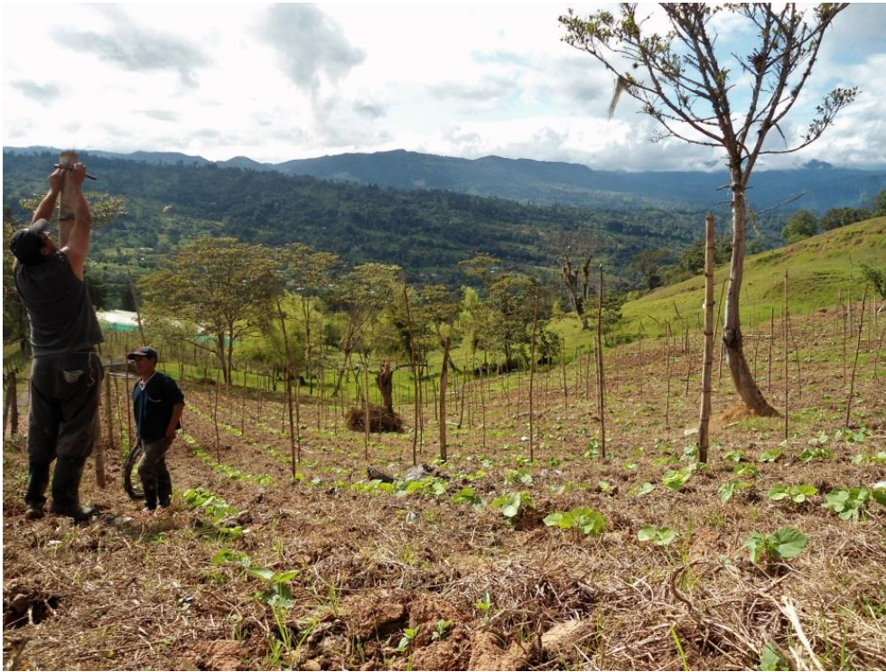
Figura 14. Jornaleros templando el alambre de la estructura.
