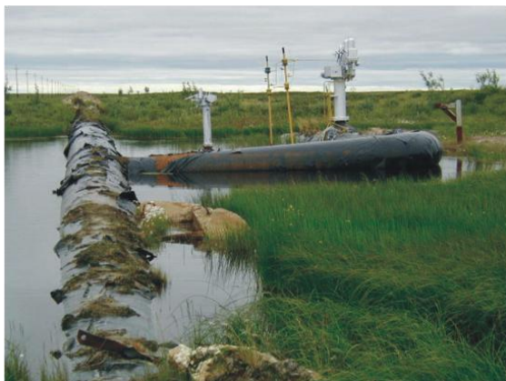
Рис. 1. Последствия, вызванные таянием многолетнемерзлых пород [6]
