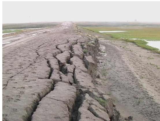
Рис. 1. Последствия, вызванные таянием многолетнемерзлых пород [6]
