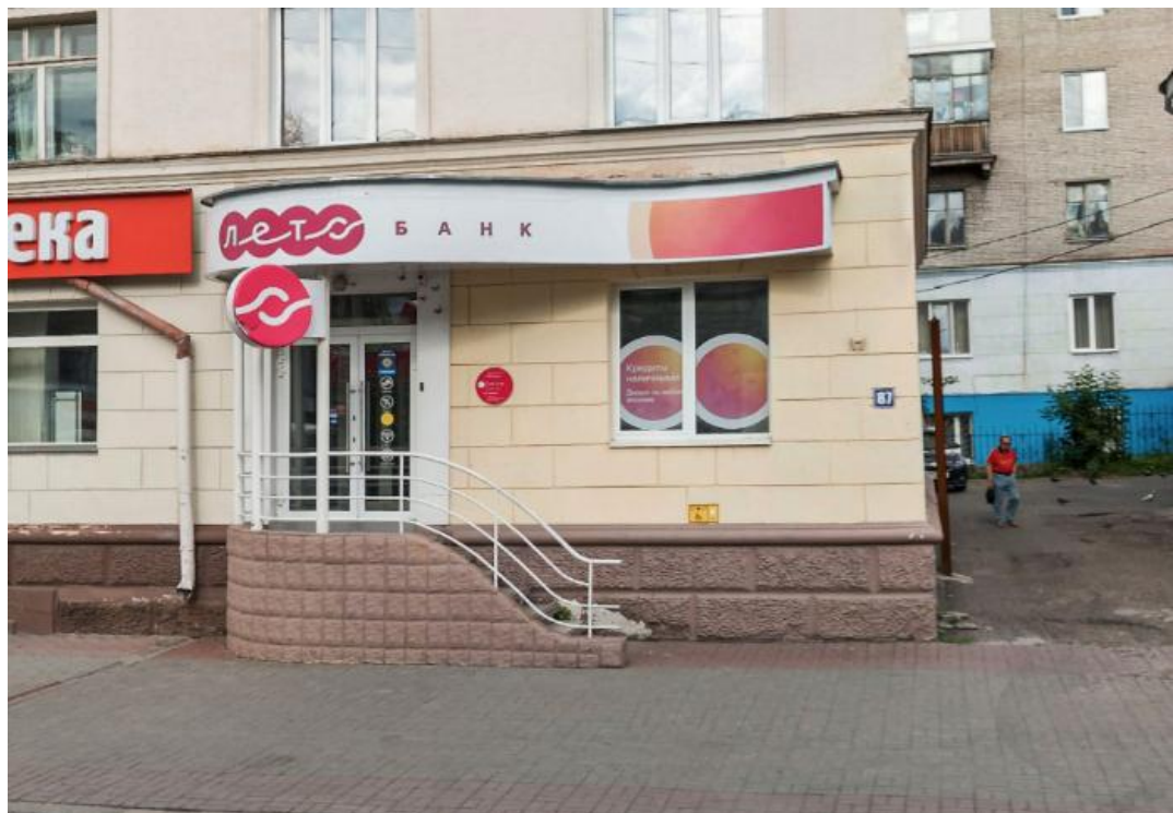
рис.65. Рисунок 14 - Конструкция над входом не соответствует архитектуре фасада
