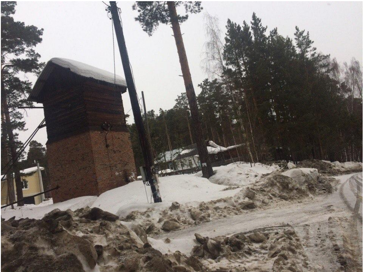
Рис. 10. Водонапорная башня и скв. № 92/81, с. Тимирязевское, ул. Октябрьская, 71/8 (фото автора)
