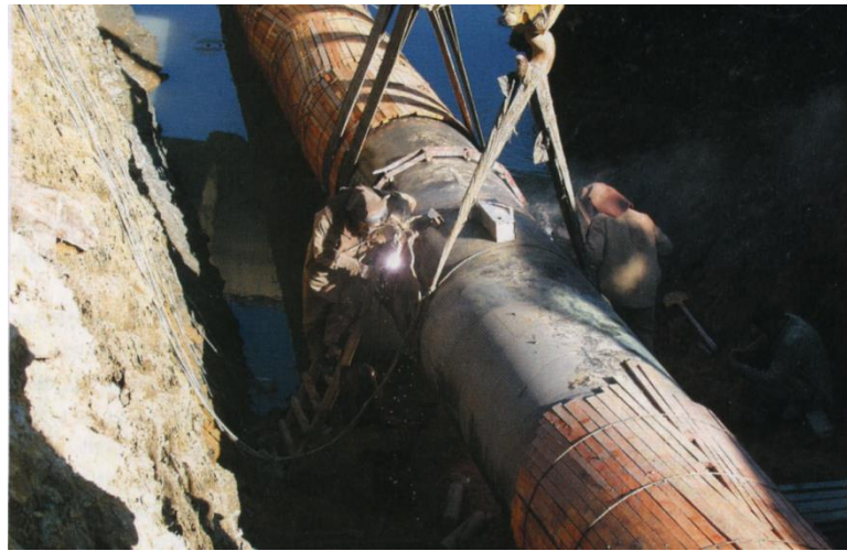
Рис. 4.1.3.1 – Футеровка трубопровода деревянными рейками
