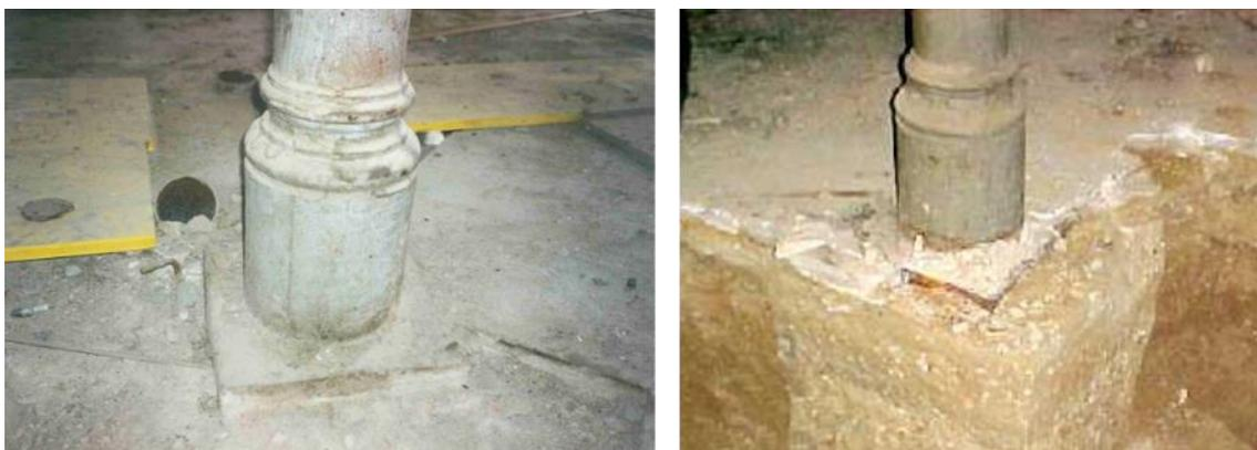
Figura 97: Asiento de pilar de planta baja sobre zapata aislada.
