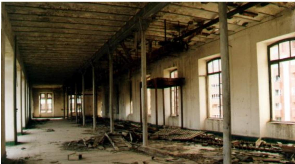
Figura 75: Planta de caídas de la fábrica de harinas Fontecha y Cano SA. 2000. Suspendeda bajo techo la transmisión movía los planchisters del último piso.
