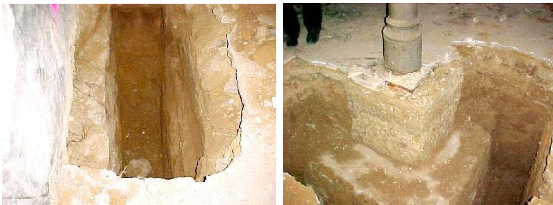
Figura 83: Catas en cimentación. Zapata corrida bajo muro y zapata aislada bajo pilar.
