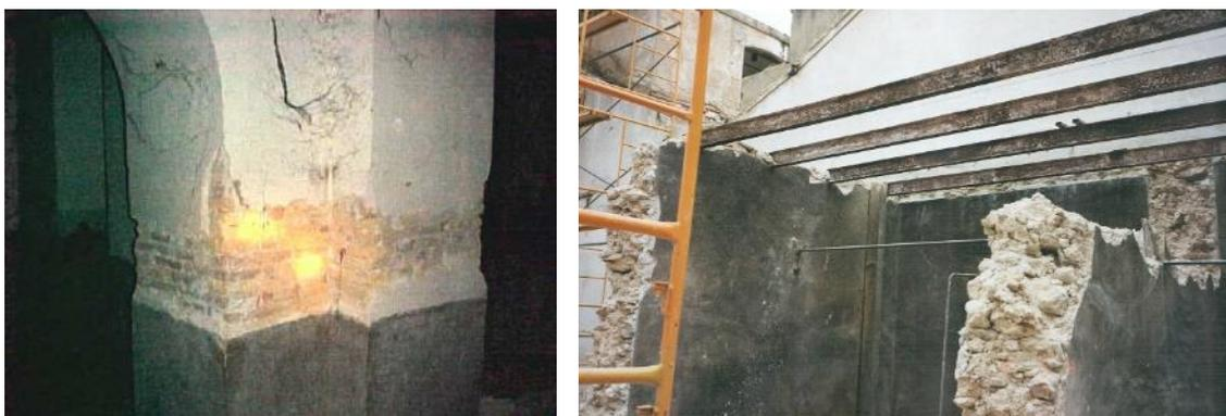
Figura 87: Muros en zona de tolvas (ladrillo macizo) / muros de mampostería terminados con revoco de cal demolidos durante la rehabilitación.
