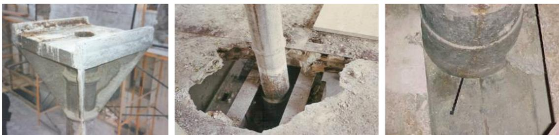
Figura 102: Capitel / Unión pilar-pilar con ausencia de contacto con vigas gemelas / Detalle apoyo pilar sobre capitel de pilar inferior.
