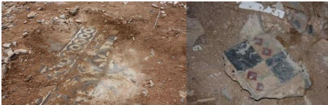
Figura 143: Solado de baldosas hidráulicas.
