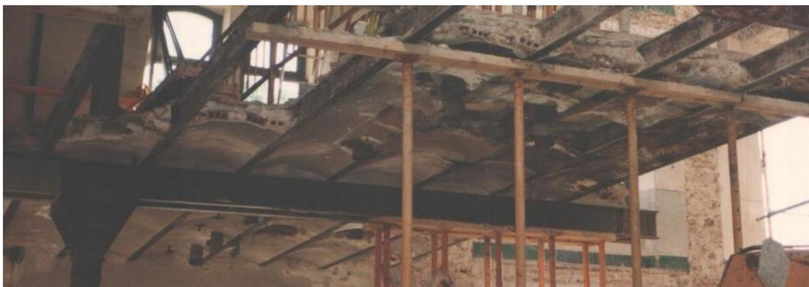
Figura 112: Entrevigado macizado con revoltón de ladrillo hueco cerámico y relleno de senos con mortero de cal.
