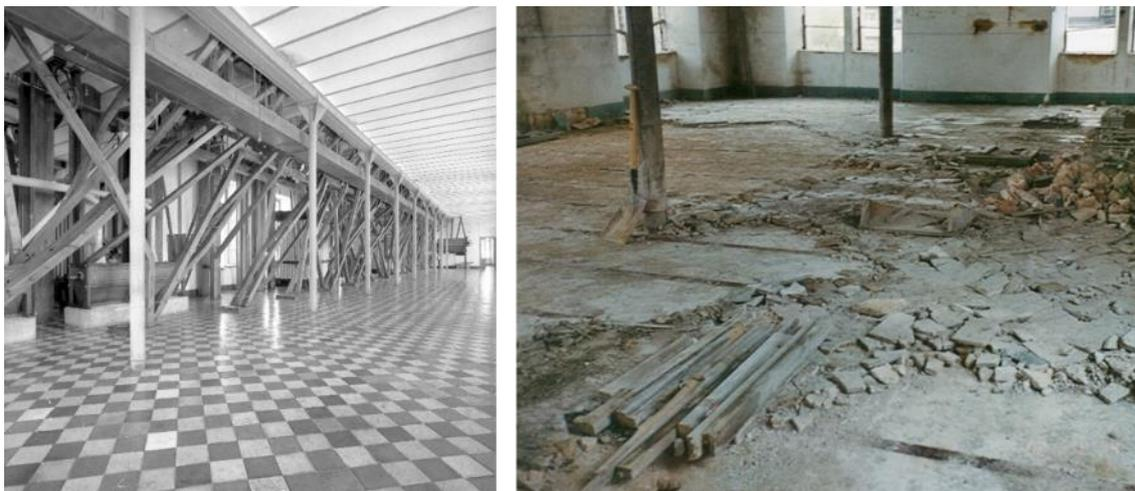
Figura 111: Pavimento de suelo hidráulico fábrica en funcionamiento / Escombros de pavimento sobre la cara superior del forjado, el entrevigado se enrasa con la cara superior de las viguetas.
