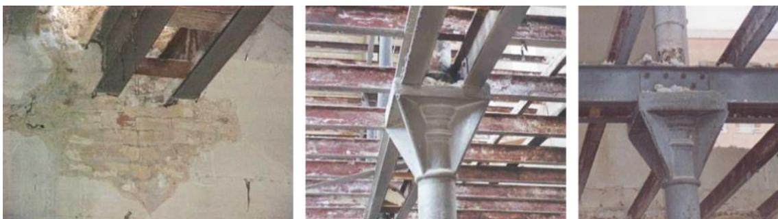
Figura 108: Fábrica de harinas de Albacete apoyo de las jácenas en muro / Apoyo intermedio de las jácenas en capitel de pilar / Continuidad perfiles.
