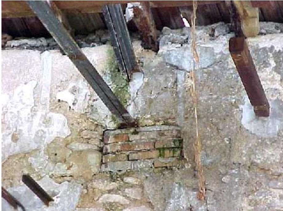
Figura 118: Apoyo de cercha sobre muro.
