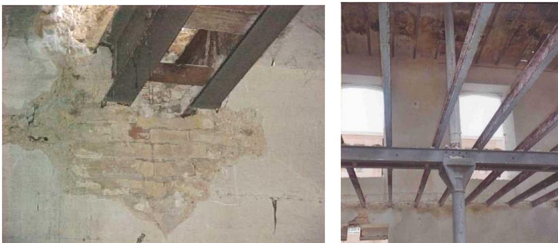
Figura 88: Apoyo de vigas y viguetas sobre muro
