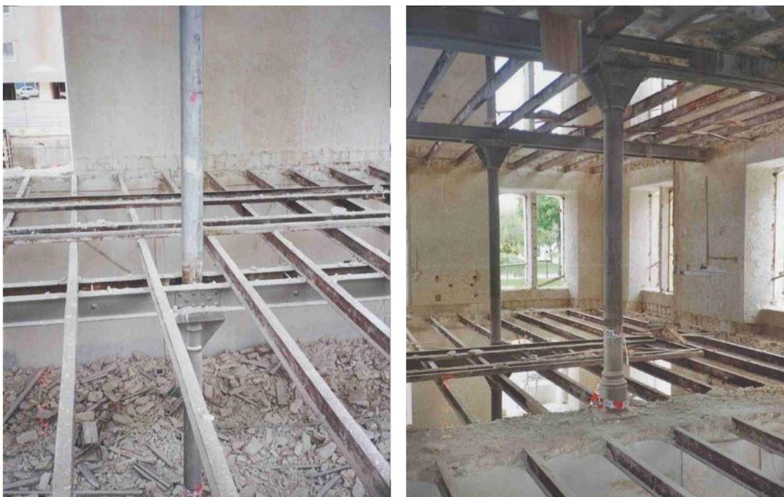
Figura 110: Viguetas de forjado de 9 m de longitud apoyadas en la viga y empotradas en el muro.
