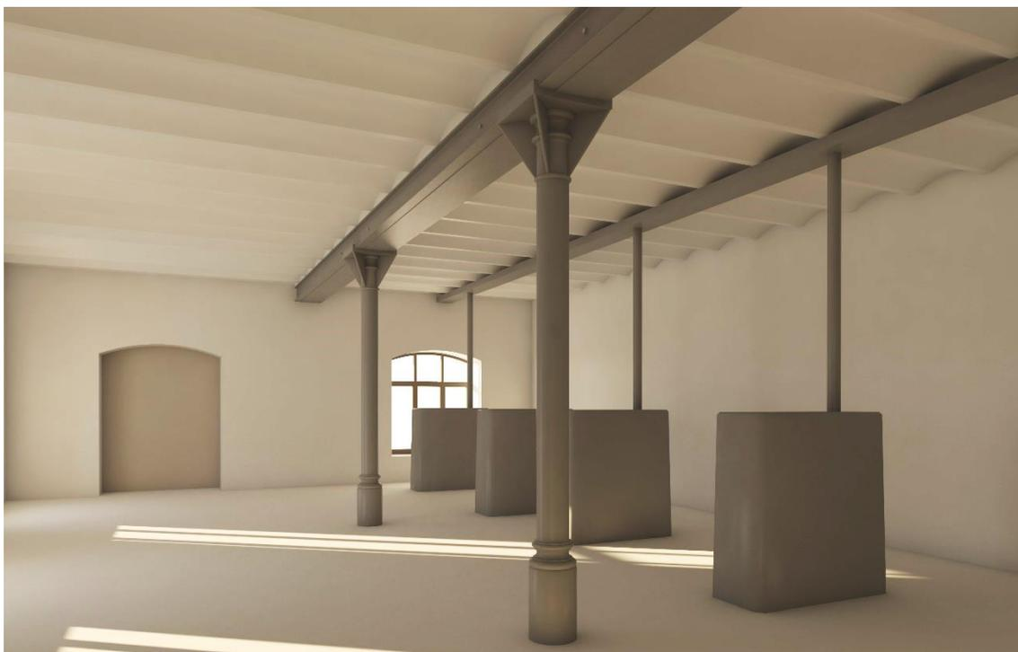
Figura 69: Imagen virtual de la edificación. Planta baja. Se aprecian los dados de hormigón que soportaban el eje y subestructura para reforzar el forjado de planta de molinos.
