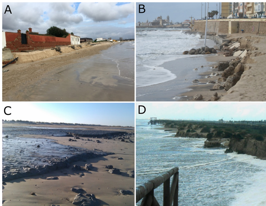
Fig. 1. Ejemplos de efectos de temporales recientes en diversas playas de la provincia de Cádiz. A) Afloramiento de tuberías y escarpes generados tras un temporal en la playa del Rinconcillo (Algeciras). B) Escollera dañada al norte de la playa de La Victoria (Cádiz). C) Erosión costera y afloramiento de la antigua marisma subyacente a la playa de Camposoto (San Fernando). D) Escarpes y desbordamiento del cordón dunar en la playa de Camposoto (San Fernando).
