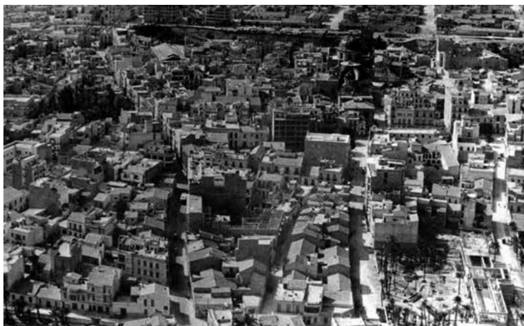
Fig. 9. Vista aèria del centre de la ciutat el 1960. En l'angle inferior dret, el Col·legi Ferrández Cruz en construcció.
