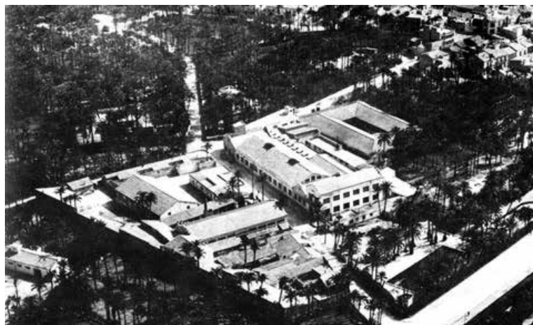
Fig. 10. Vista aèria de la seu provisional de l'INEM l'Assumpció.
