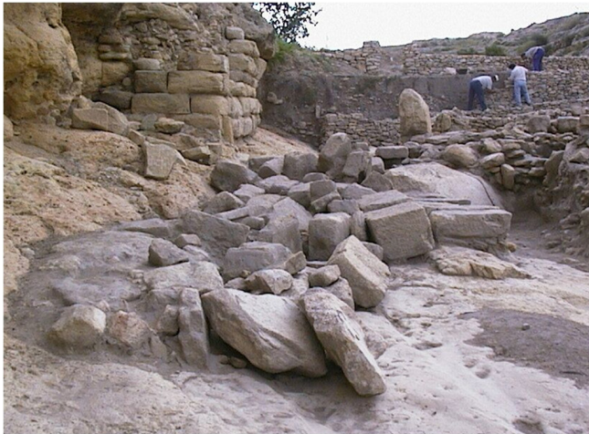
Fig. 6. Derrumbe sobre el camino de acceso, lienzo septentrional del baluarte visigodo.
