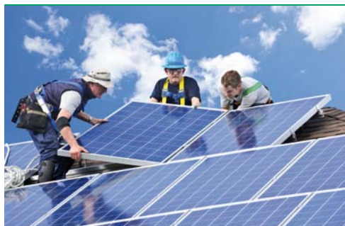
■ Abb. 5: Montage von Solarpanels auf Privaddächern (sst).
