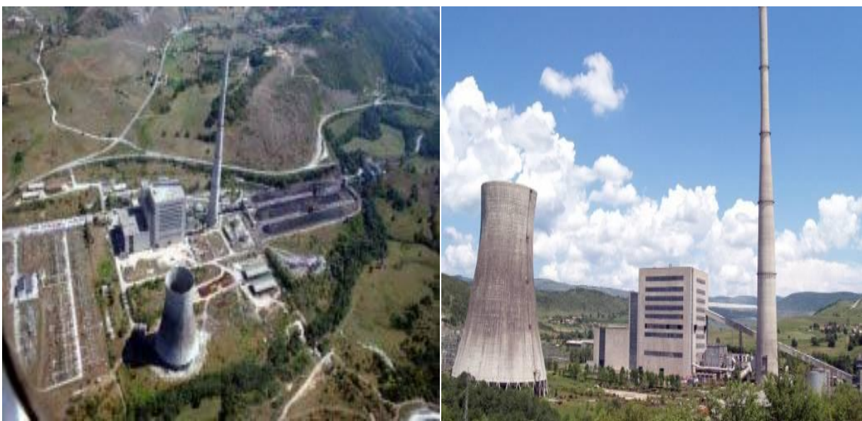
Slika 3.16: Termoelektrarna Pljevlja (Vir: Google)
