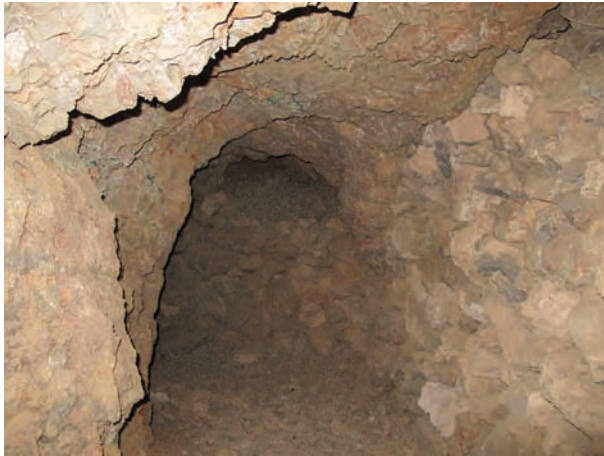
Figura 3.69. Galería con fortificación lateral de la mina de Bolnuevo.
