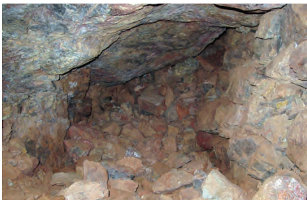
Figura 3.43. Tramo de galería de aspecto prehistórica cuyo techo muestra las formas típicas asociadas a un ataque por fuego.
