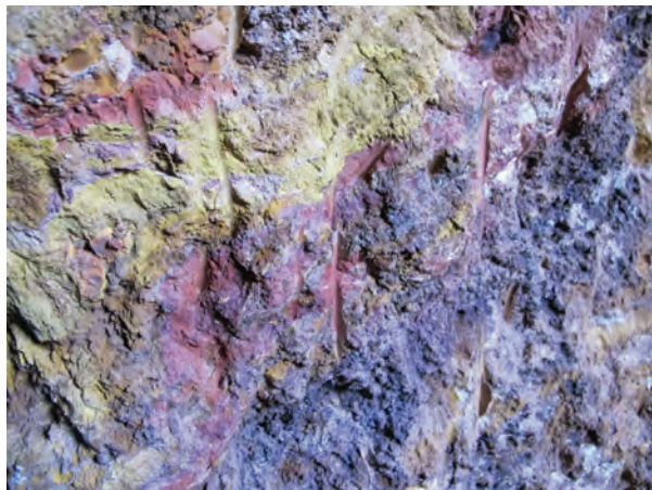
Figura 3.81. Pared de galería de hidróxidos de hierro (ocres) con marcas de pico metálico.
