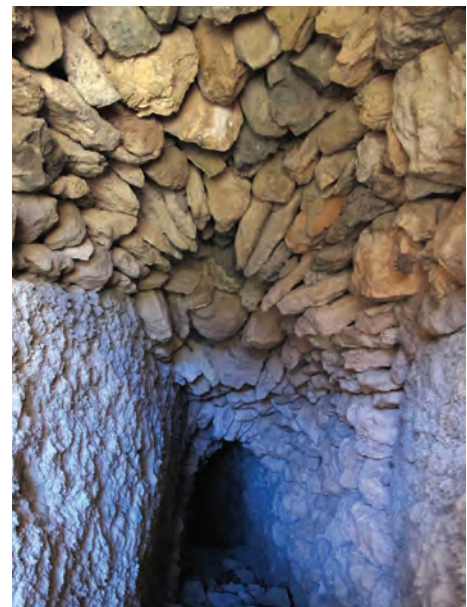
Figura 3.82. Interior del socavón del Collado del Bolete con el arco de la bóveda fortificado en mampostería en seco.
