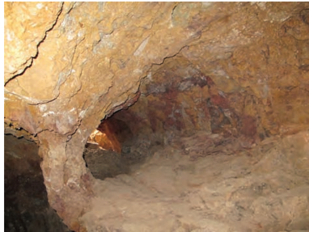
Figura 3.88. Galería antigua seccionada por labores modernas que dejaron un pilar de sustentación. Este pilar, picado recientemente por coleccionistas de minerales está fuertemente mineralizado.
