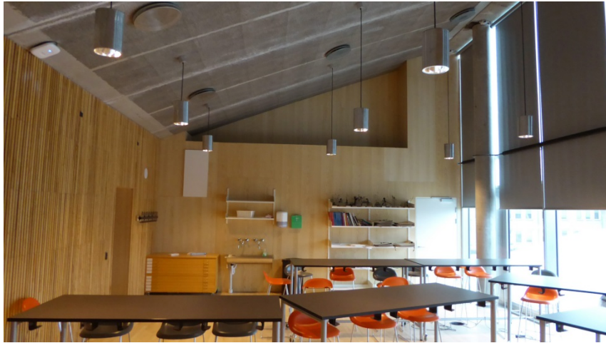
Figur 3.4.5.1. Klasseværelse i Gl. Hellerup Gymnasium med lydabsorberende SL-dæk i loftet. Foto: K. Hertz.
