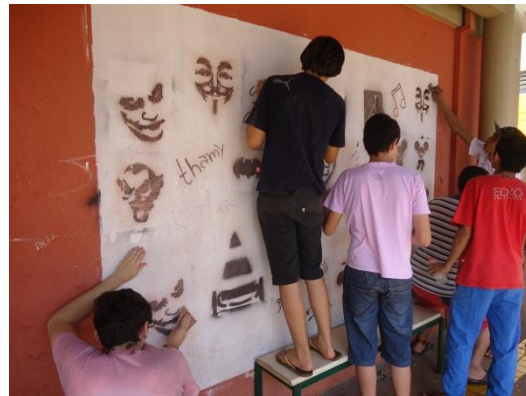
Alunos lixando a parede para neutralizar os estênceis e pichações feitos na parede.
