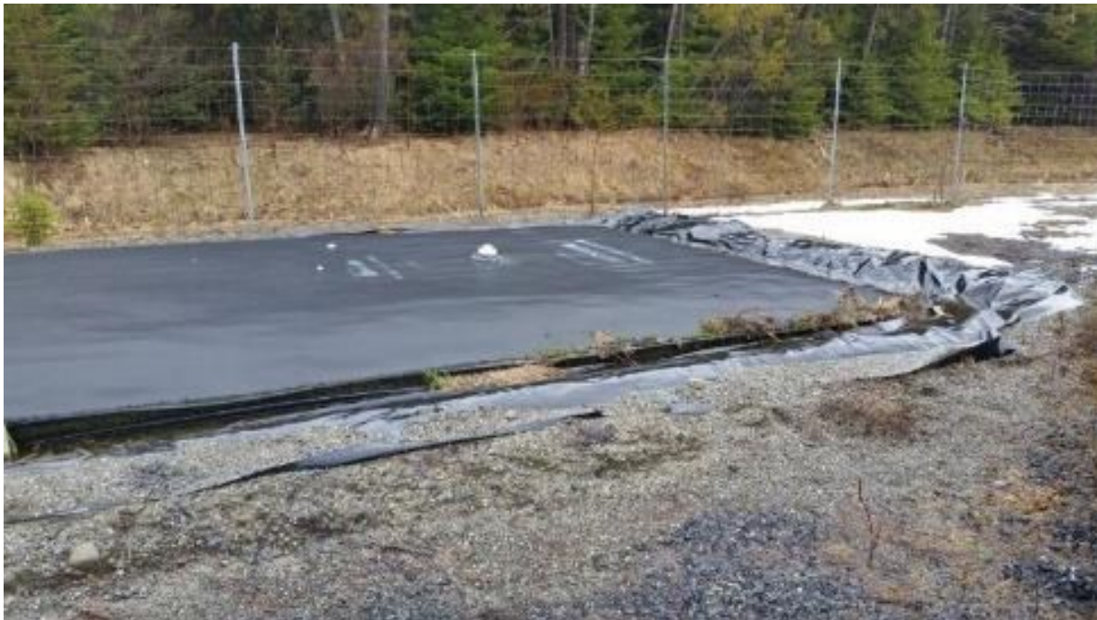
Figure 4.3 Sac géotextile pour la déshydratation des boues (usine EA, Sainte-Cecile-de-Whitton, avril 2017)
