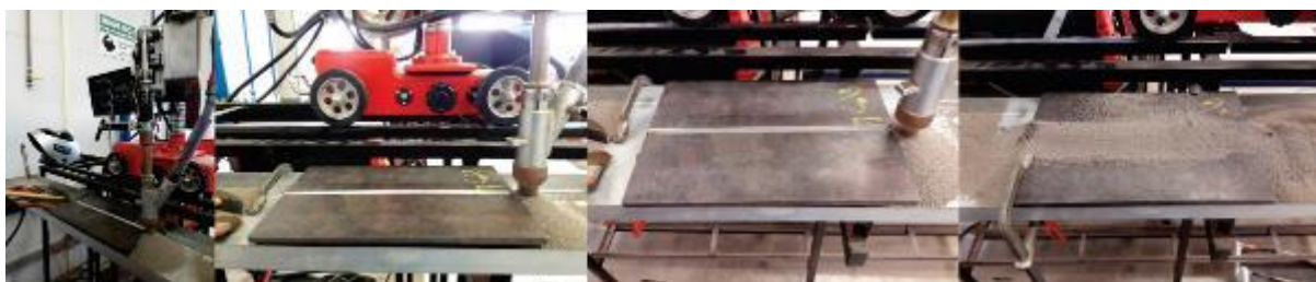
Figura 25 – Processo de soldagem.
