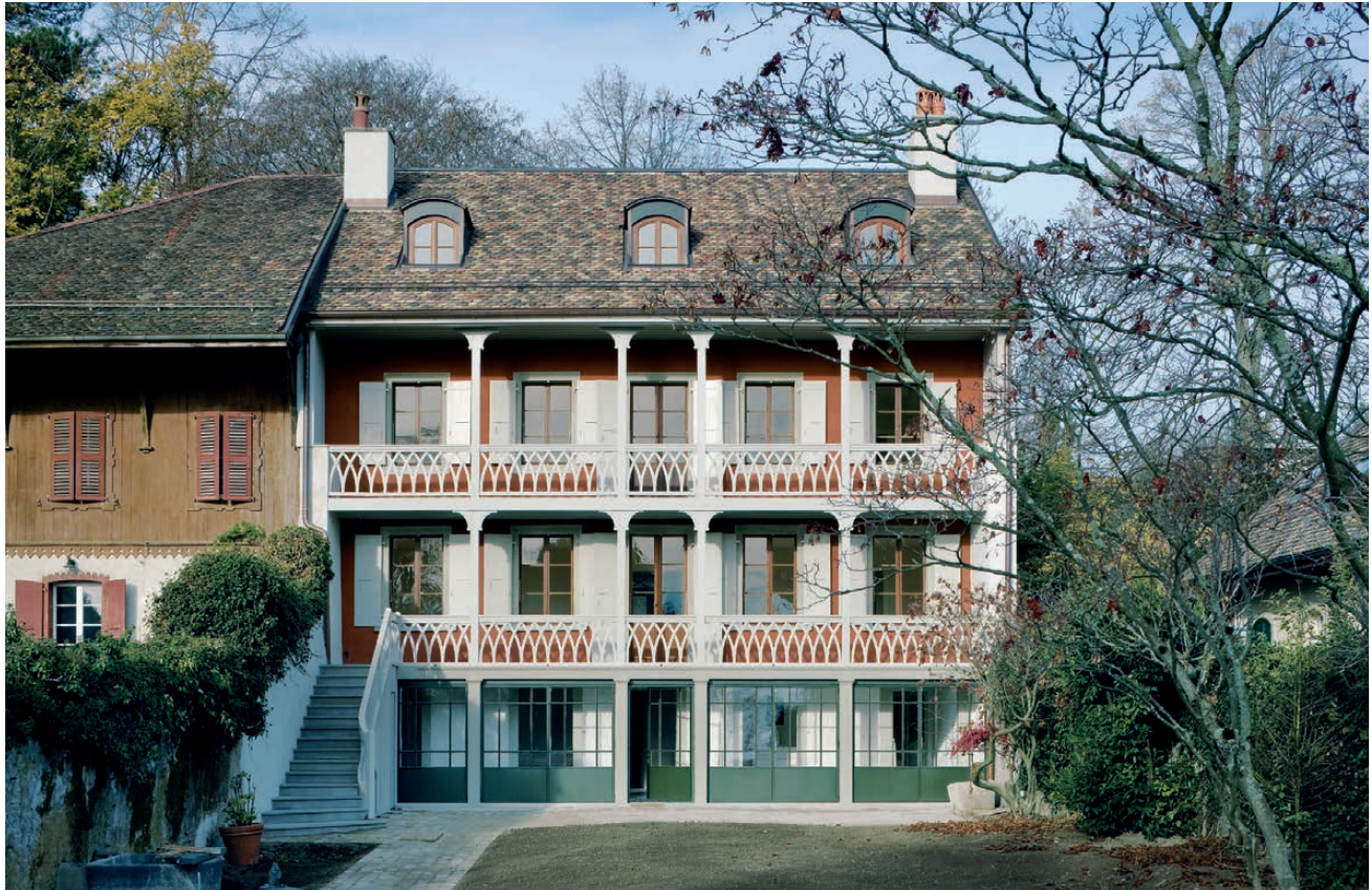
Die vorgelagerte Treppe, das neu ausgebaute Untergeschoss und die Dachgauben geben dem ursprünglichen Bestand eine neue Prägung, ohne den Gesamteindruck grundsätzlich zu verändern.
