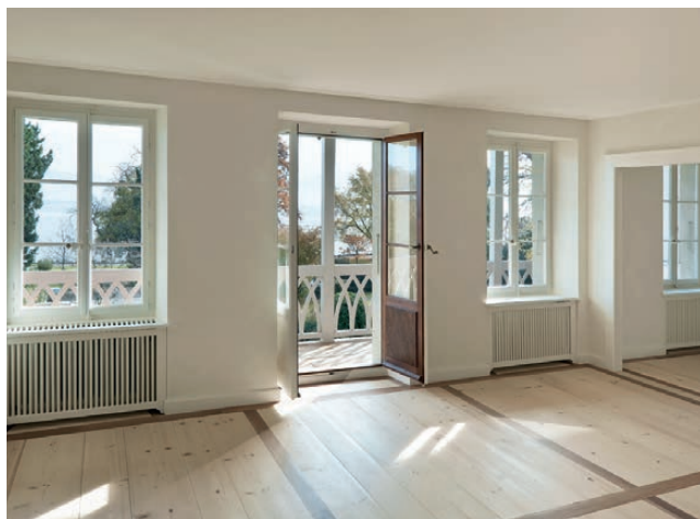
Die grafischen Muster im Parkett betonen die Achsen des Innenausbaus. Durch die reduzierte Formensprache bleibt der Boden als hinzugefügtes Bauteil erkennbar.
